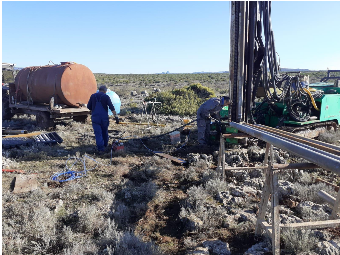
Ubicazione Sondaggio NA-02
