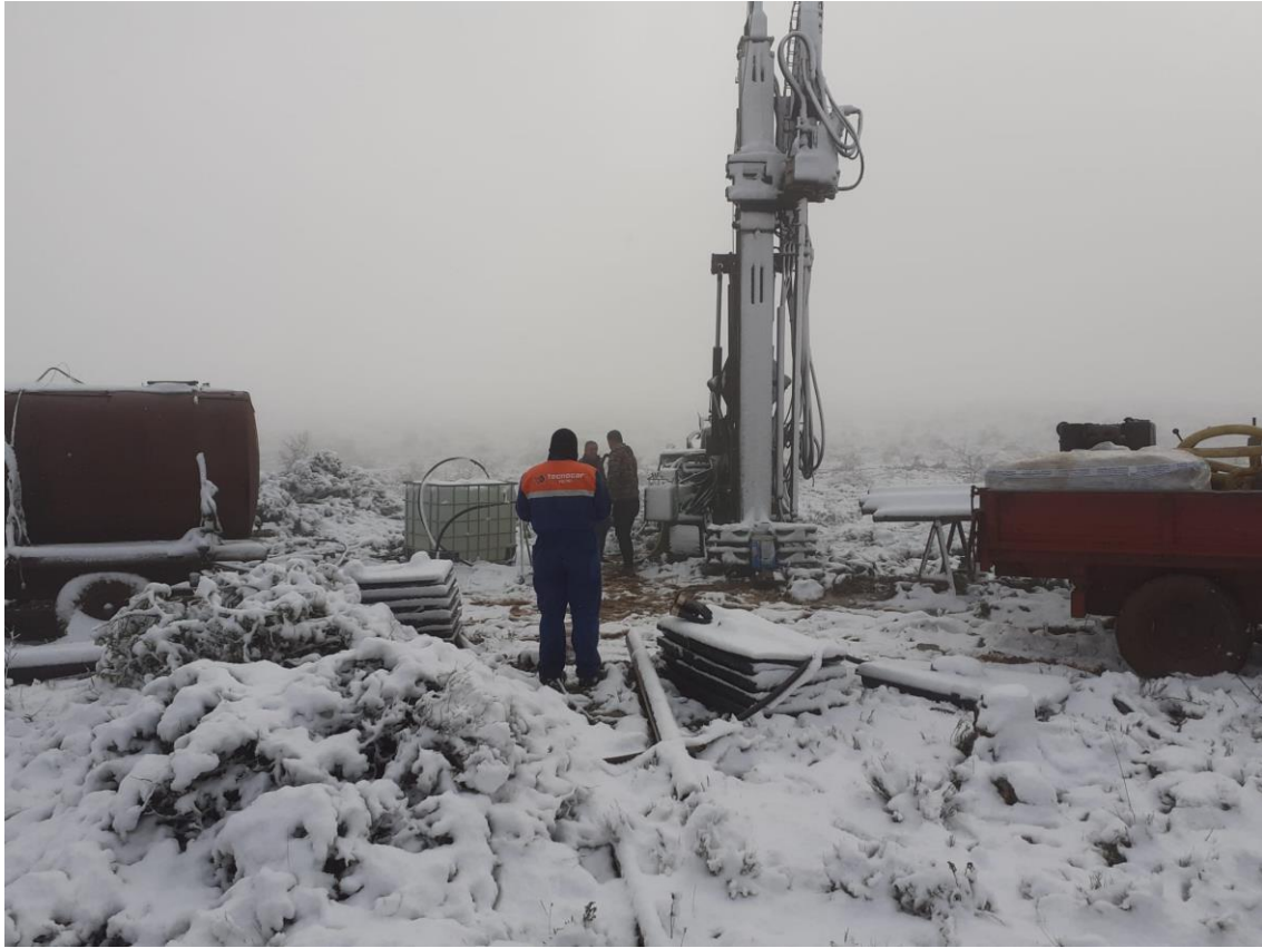
Ubicazione Sondaggio NA-03
