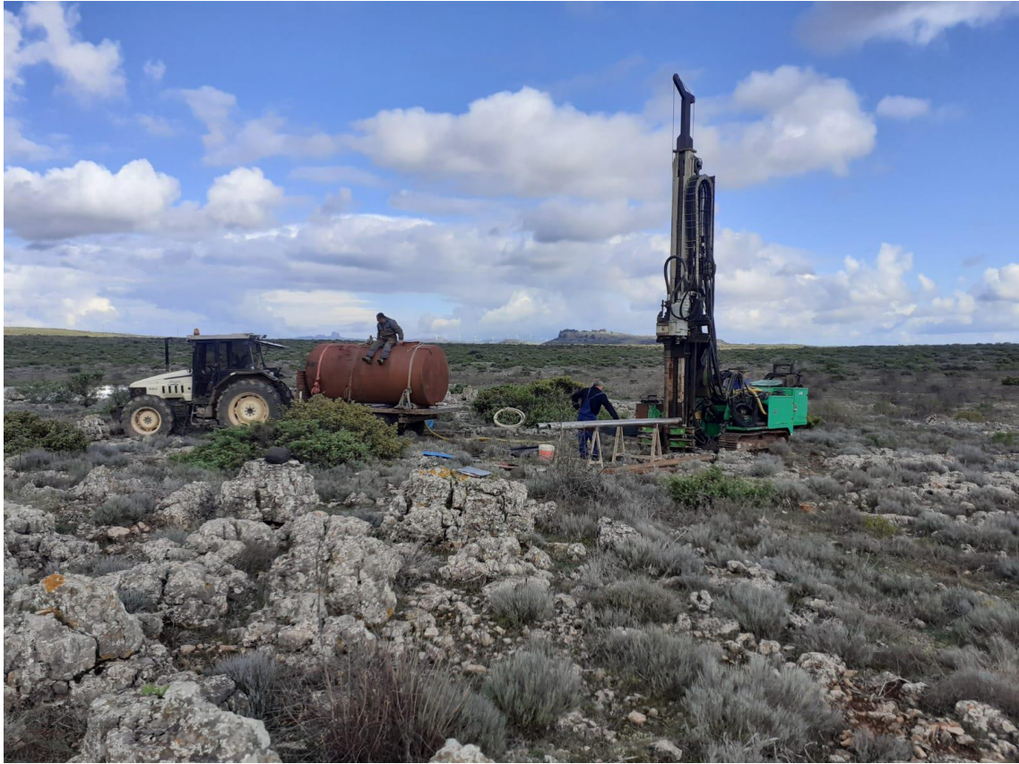
Ubicazione Sondaggio NA-01
