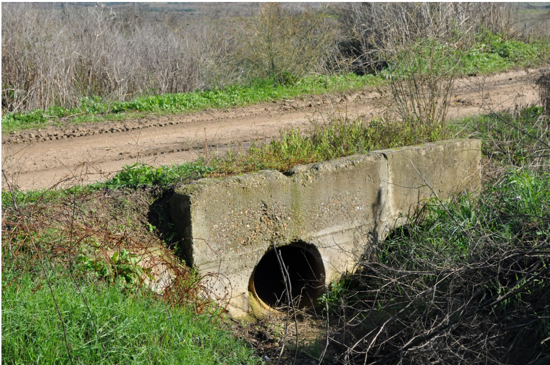
Particolare dell'attraversamento del Rio Sassuni della strada in previsione di utilizzo per l'accesso alla futura SE
