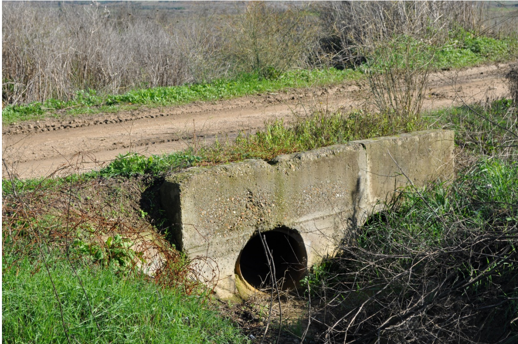
Attraversamento Rio Sassuni lato di valle
