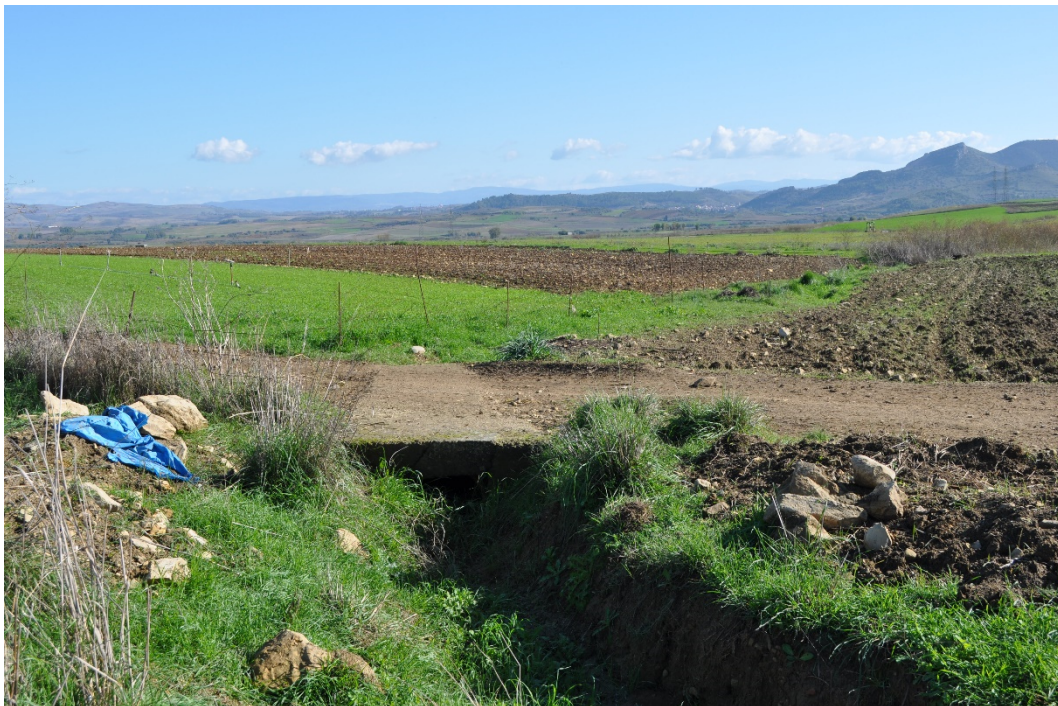
Attraversamento Rio Sassuni lato di monte
