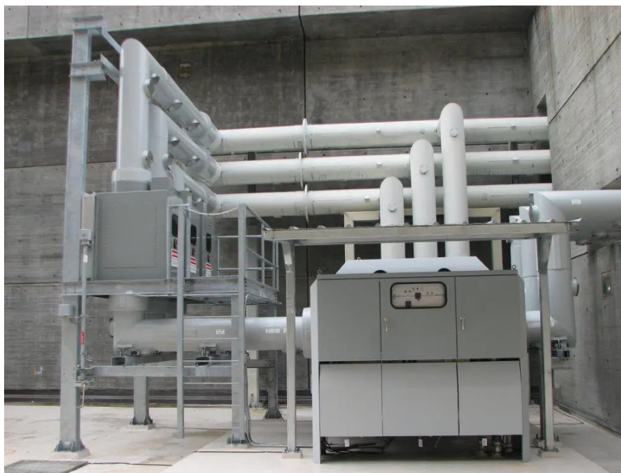
Figura 3 - esempio di installazione Sistema IPB (Isolated Phase Bus)
