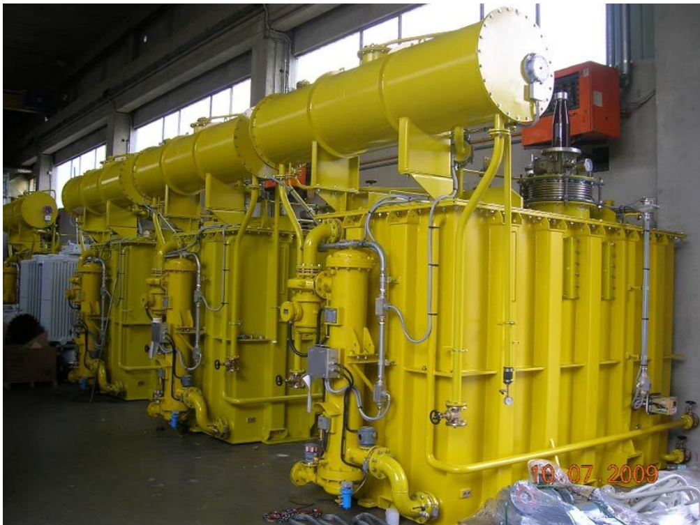
Figura 4 - esempio di trasformatore monofase analogo a quello in progetto
