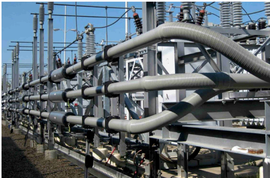
Figura 2 - esempio di installazione Sistema IPB (Isolated Phase Bus) – fonte: Duresca ® Bus bar system (Moser Glaser)
