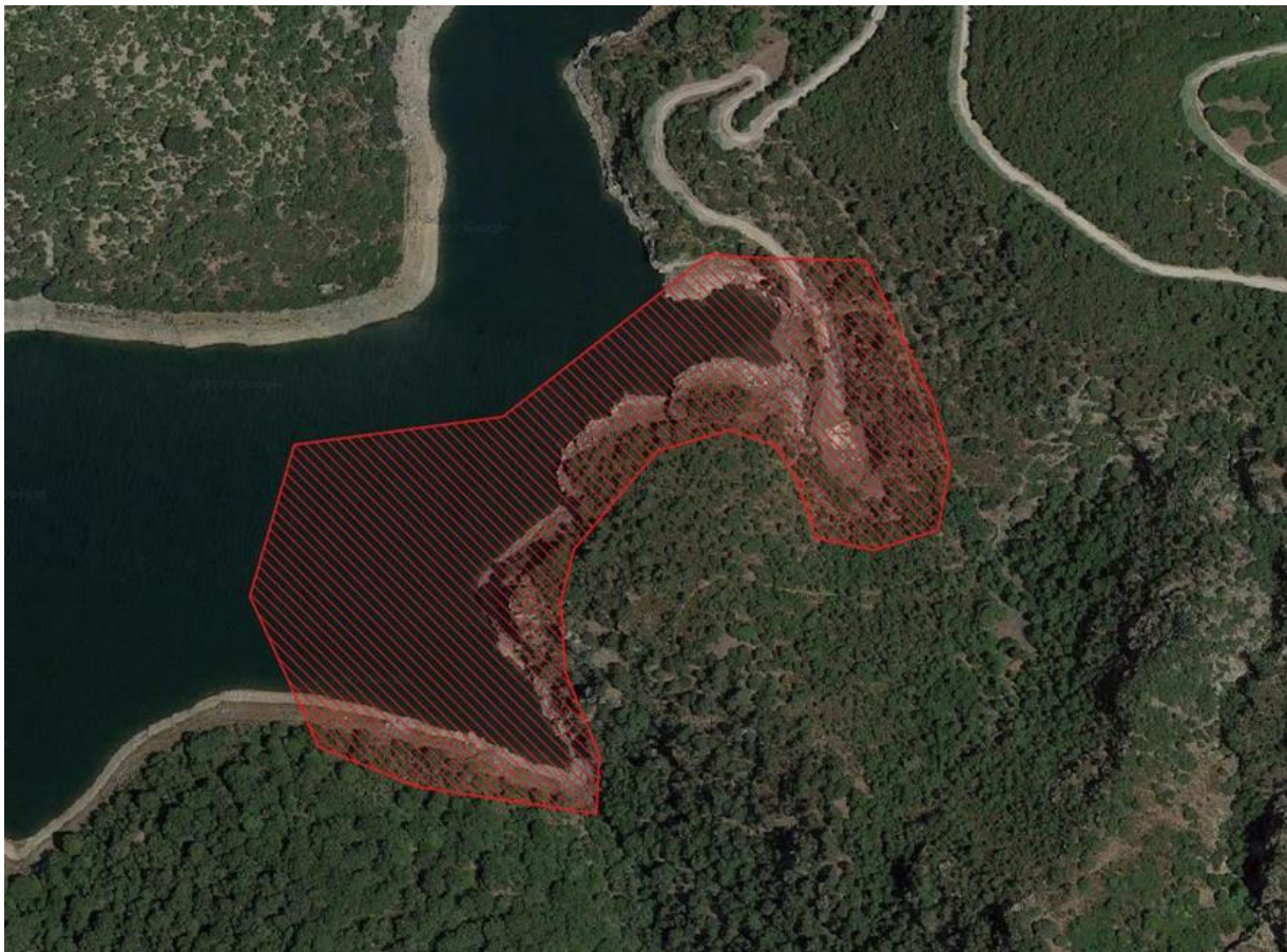
Figura 4.8: Area di Cantiere di Valle
