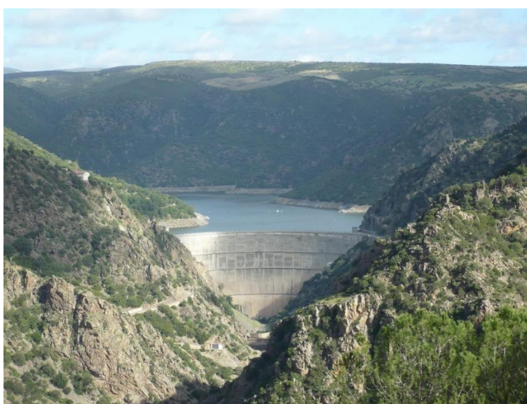
Figura 4.3: Diga di Nuraghe Arrubiu vista da Valle (Fonte: http://www.enas.sardegna.it/il-sistema-idrico-multisetoriale/laghi-artificiali/nuraghe-arrubiu.html )
