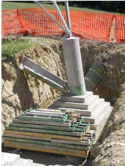
Figura 31: Realizzazione di fondazioni superficiali tipo CR per un sostegno a traliccio. Nell'immagine si può osservare una fondazione CR appena "scasserata". Si possono distinguere facilmente la parte inferiore a parallelepipedi tronco piramidali ed il colonnino di raccordo con la "base" del sostegno (immagine d'archivio)
