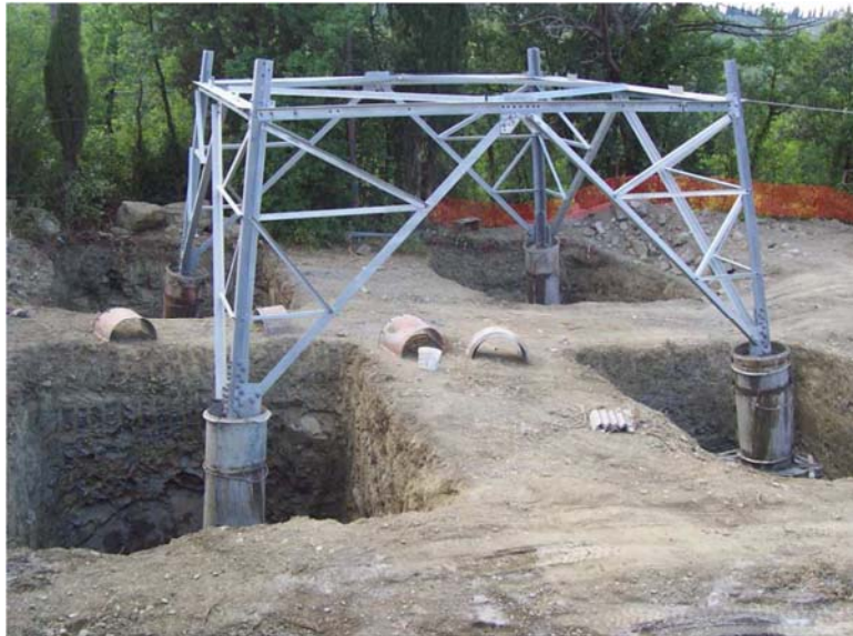
Figura 30: realizzazione di fondazioni superficiali tipo CR per un sostegno a traliccio. Nell'immagine si possono osservare le quattro buche, la base del sostegno collegata alla fondazione tramite i "monconi" ed i casseri utilizzati per i quattro "colonnini" (immagine d'archivio)
