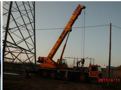
Esempio: Alcune fasi di montaggio del sostegno a traliccio
