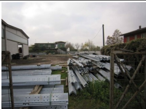
Deposito temporaneo di materiale in un cantiere Base – Foto di repertorio
