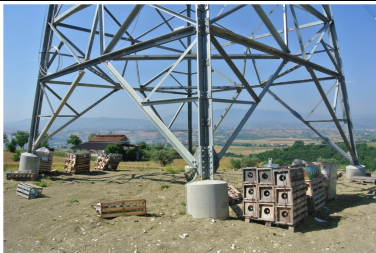
Esempio: Deposito temporaneo di materiali nell'area di microcantiere
