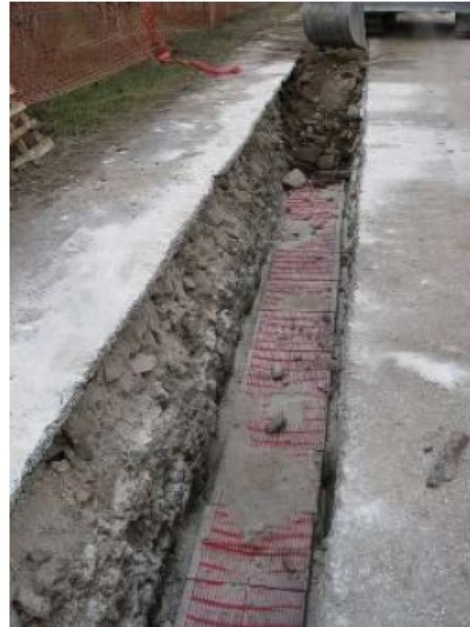
Rinterro con posa delle piastre di protezione e rete PVC
