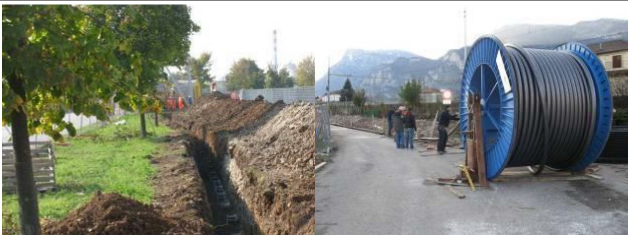
Posa dei rulli lungo lo scavo e stendimento del cavo
