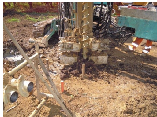
Esempio: Macchina operatrice per la realizzazione di micropali tubfix; sistema di scavo mediante trivella elicoidale
