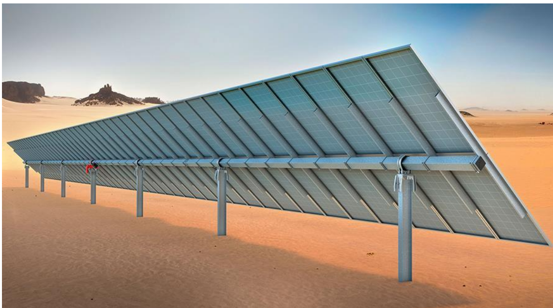
Figura 24: Immagine qualitativa della struttura di supporto
