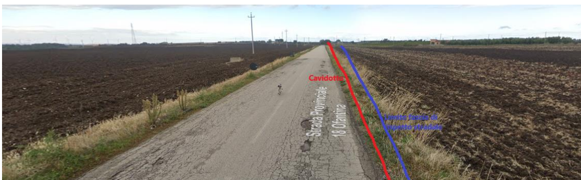
Figura 1: Stato di progetto area 2 – ripresa fotografica da Google
