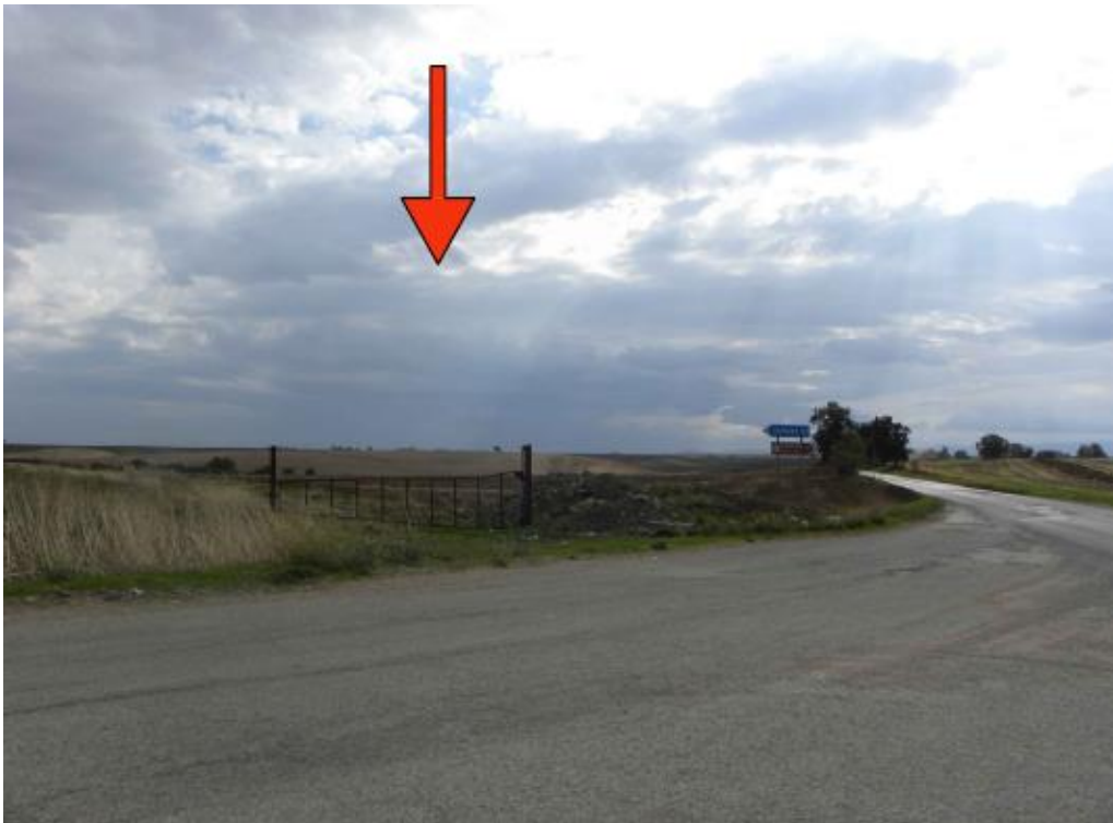
Figura 30: Veduta area di accesso dell'impianto agrivoltaico
