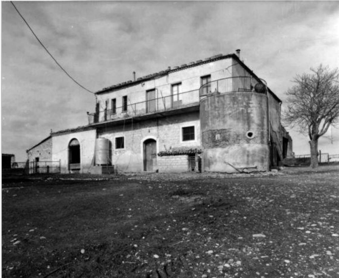
Figura 51: Masseria Casone – Foto tratta dall'archivio delle Soprintendenza Archeologica, Belle Arti e Paesaggio della Regione Basilicata
