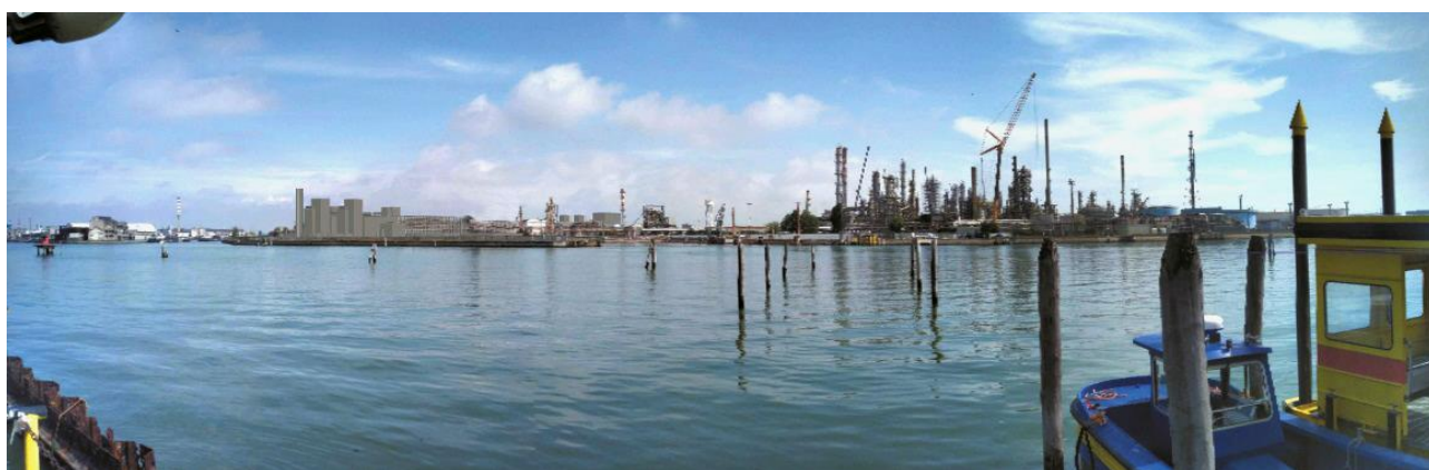
Figura 7-26 – Vista panoramica da Isola dei Petroli (post operam)
