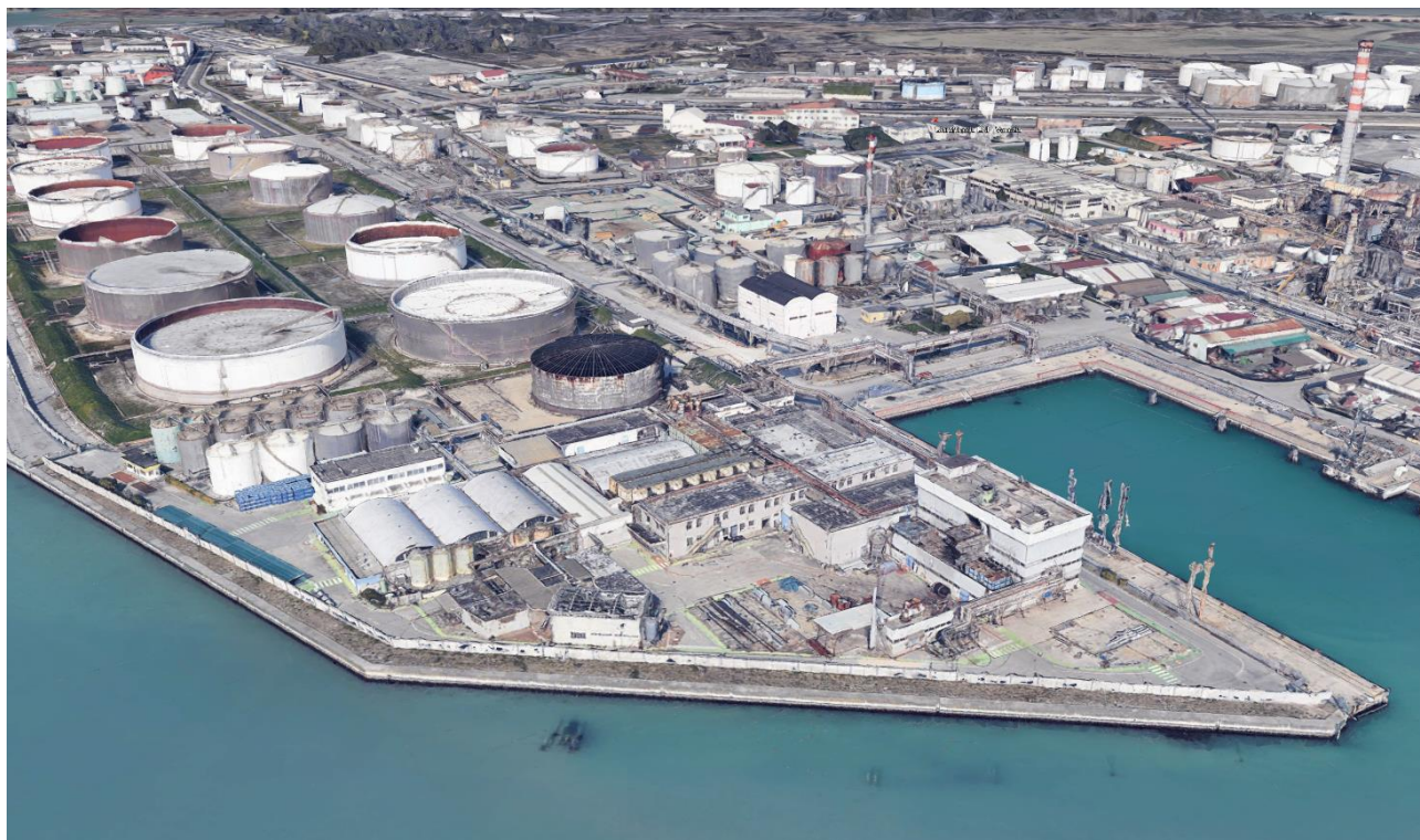
Figura 7-21 - Vista da Sud Ovest Area APL, stato ante operam (Fonte Google Earth)
