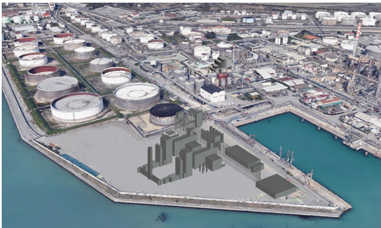
Figura 7-22 - Vista da Sud Ovest Area APL, stato post operam
