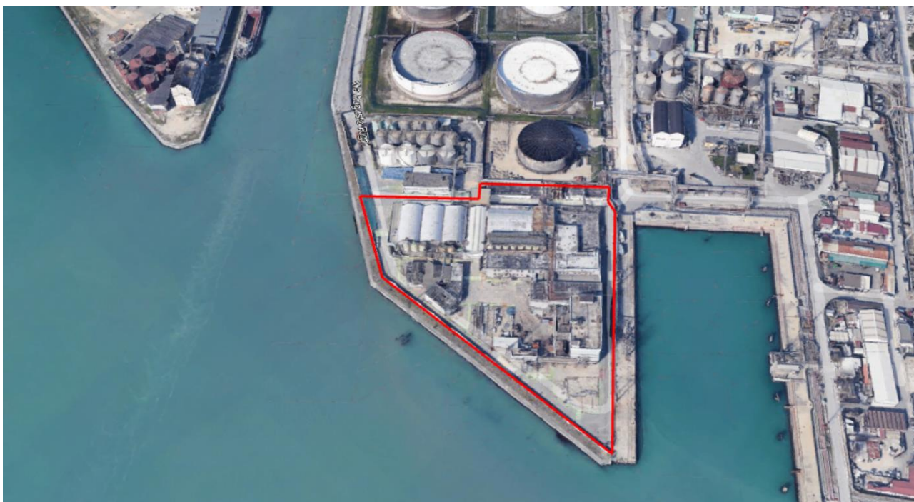
Figura 5.3: Localizzazione area disponibile per realizzazione Steam Reforming (in rosso)
