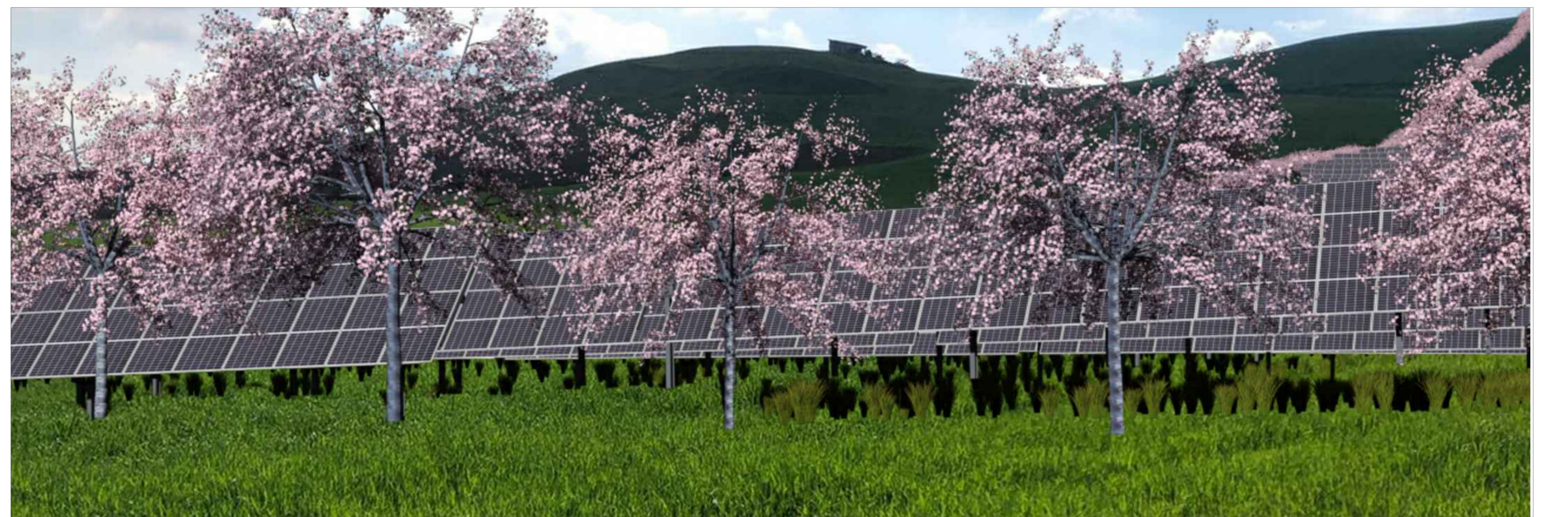
FOTO N.2 - AREA IMPIANTO CON MITIGAZIONE
