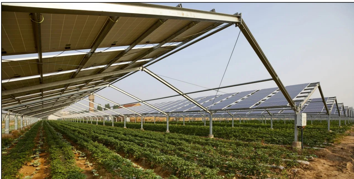
Figura 6.2. Agrovoltaico a moduli fissi con struttura a falde in Cina, in un campo coltivato a bacche di Goji
