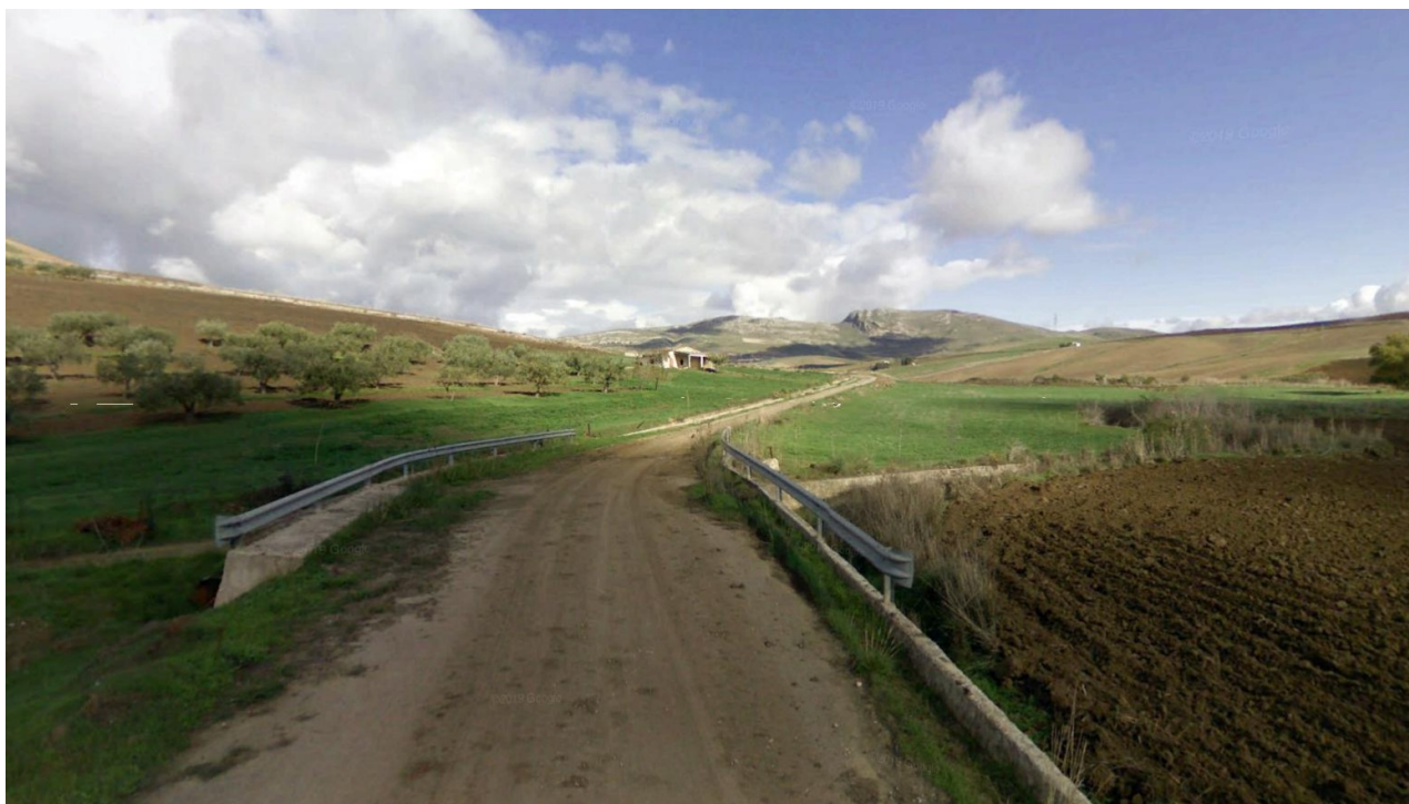
Figura 11: tratto D-E interferenza superficiale
