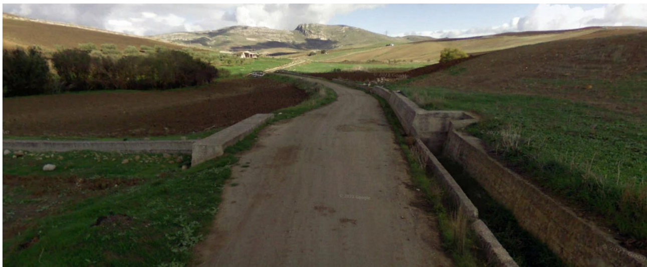
Figura 10: tratto D-E interferenza superficiale
