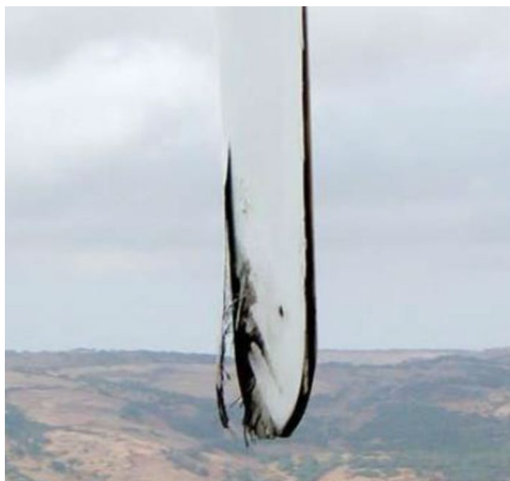
Figura 1 - Estremità della pala danneggiata da fulminazione atmosferica
