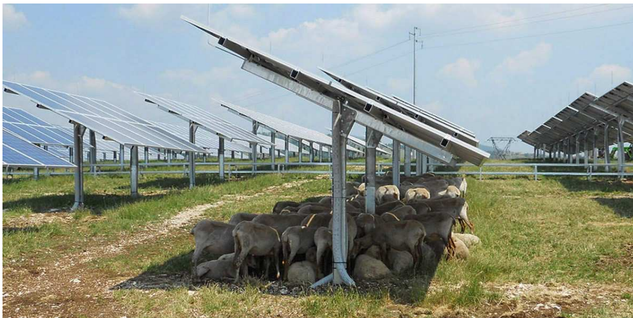
Fig. 50. Prato-pascolo aree poste sotto i pannelli
