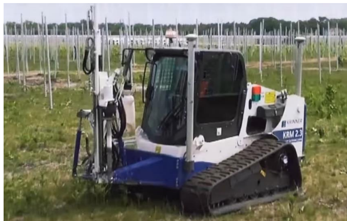
Fig. 5. Esempio di fissaggio delle strutture di supporto
