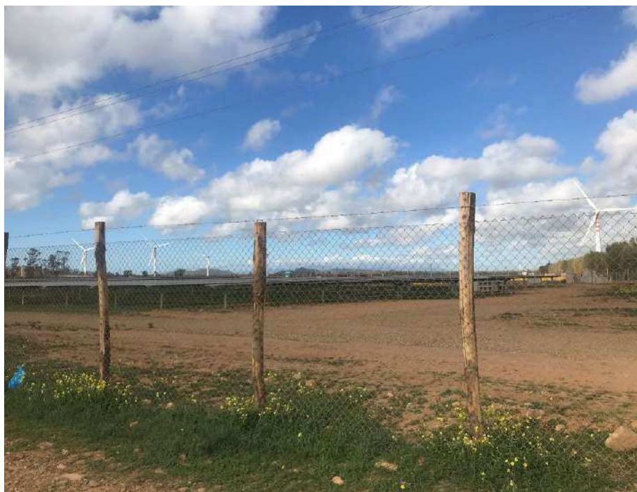
Illustrazione 3.27: Tipologia di recinzione utilizzata
