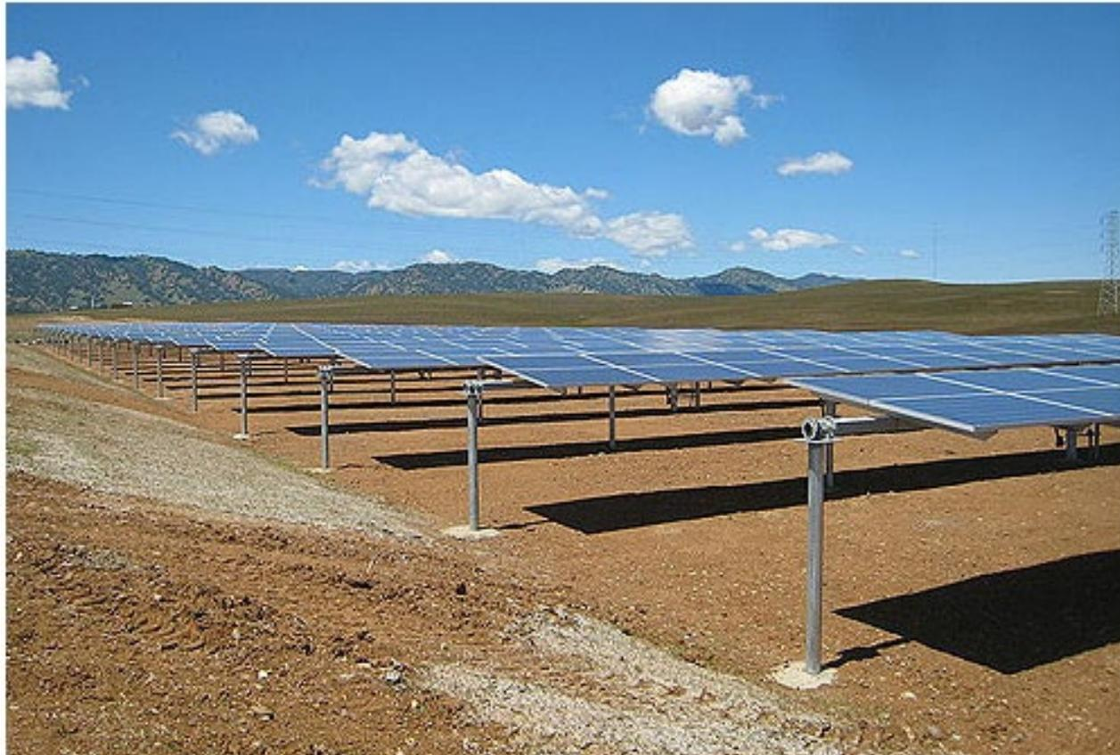
Fig. 46– Foto tipo trackers monoassiali a inseguimento solare.
