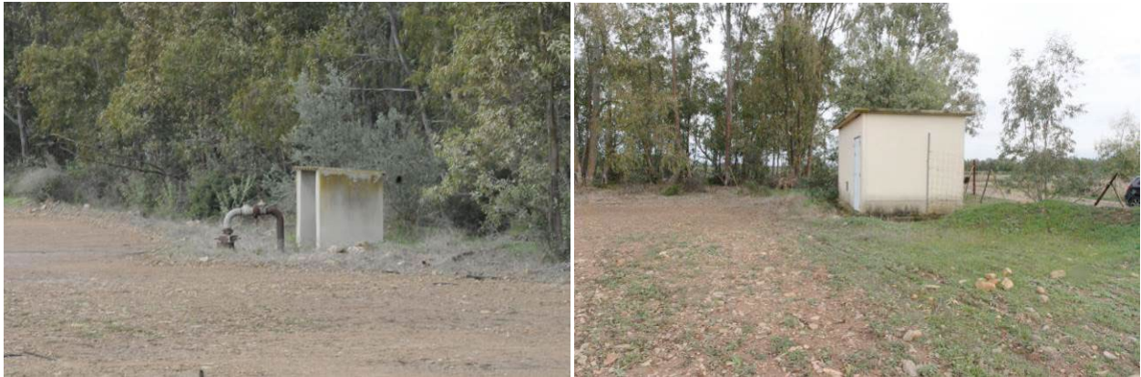
Sono ancora evidenti i terminali e le bocchette dell'impianto di irrigazione.
