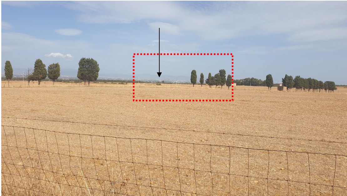
Punto di scatto n.6. Con la freccia viene indicata la torre piezometrica presente nei pressi dell'area di progetto.
