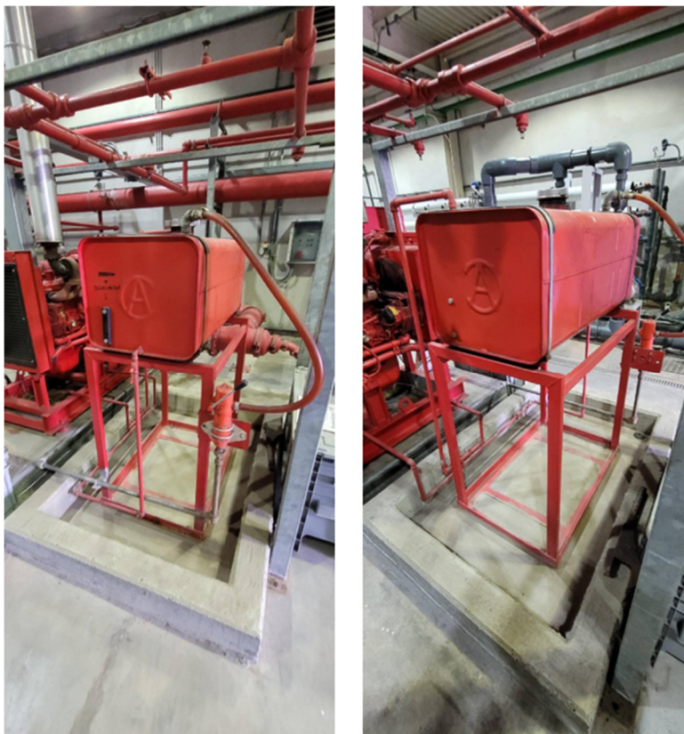
Foto 11 e 12: Serbatoio carburante fronte e retro
