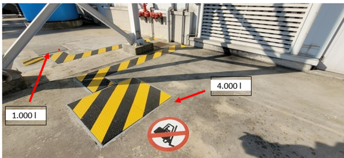
Foto 3: Pozzetti esterni dei serbatoi esterni interrati da 1000 l e 4000 l.
