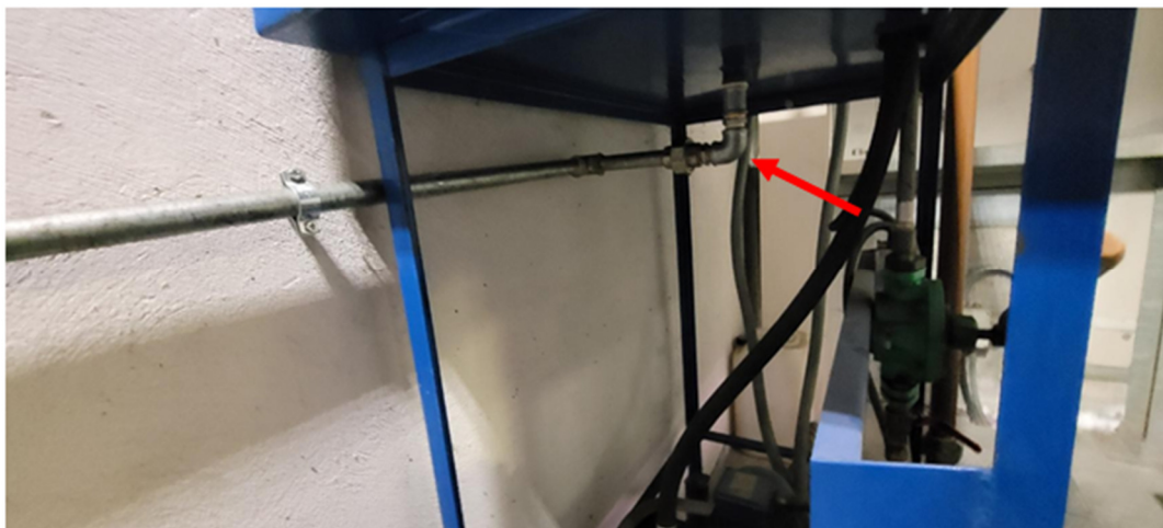
Foto 6: Catino di raccolta sottostante-vista del particolare (tubazione di raccolta perdite)
