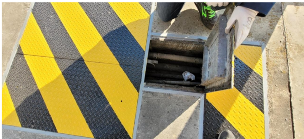
Foto 4: Serbatoio esterno 4000 l – vista delle tubazioni di mandata e ritorno del carburante.
