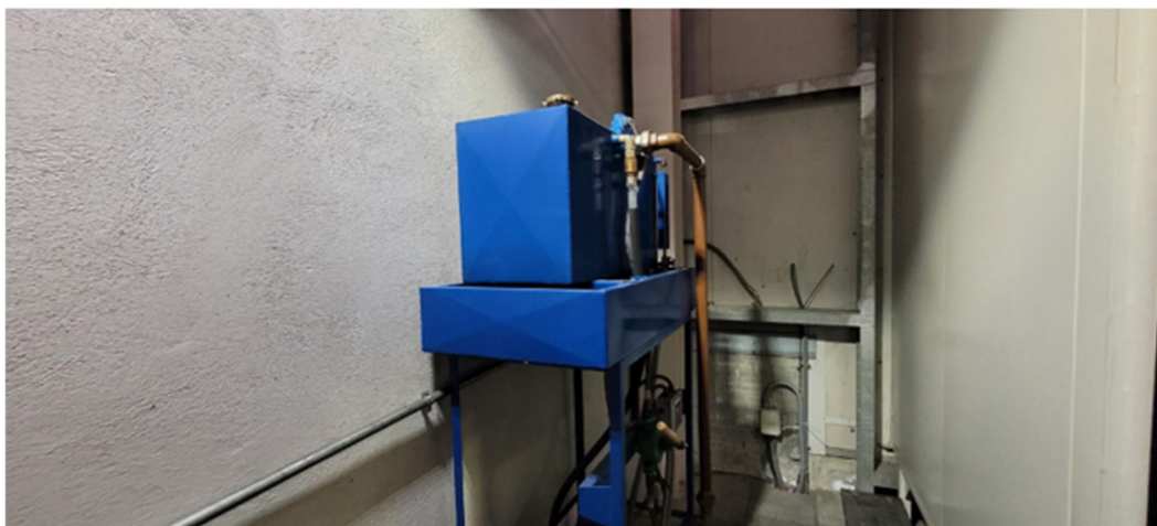
Foto 5: Serbatoio n° 1 - Interno 120 l con catino di raccolta sottostante
