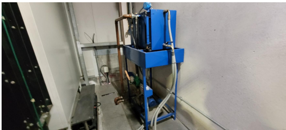
Foto 8: Serbatoio n° 2 - Interno 120 l con catino di raccolta sottostante
