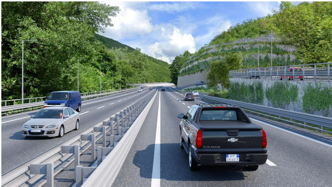
Simulazione dello svincolo con eliminazione del cavalcavia e conservazione delle sole rampe di svincolo "dirette"
