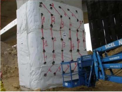
Fori realizzati in un pilastro di un ponte
