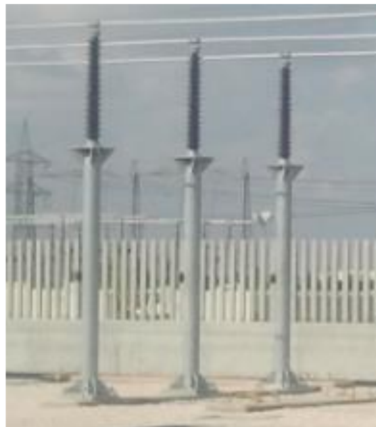
Figura 11: particolari in foto di tali supporti
