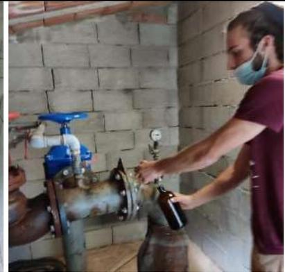
Pozzo idropotabile visto dall'esterno e dall'interno e fase di campionamento da rubinetto
