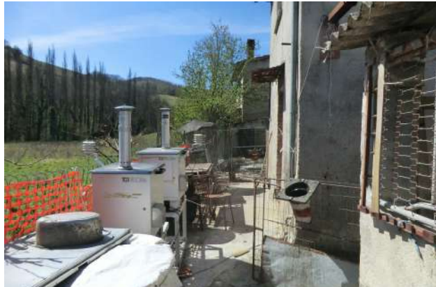
Vista verso la zona del fronte lavori
