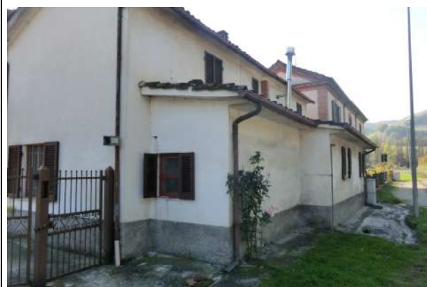
Postazione di misura dei gas
