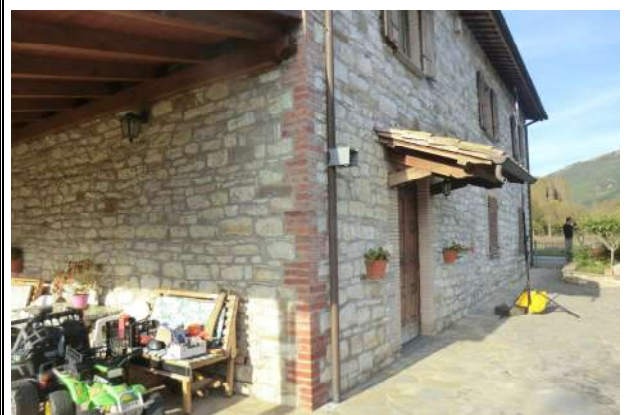
Postazione di misura dei gas
