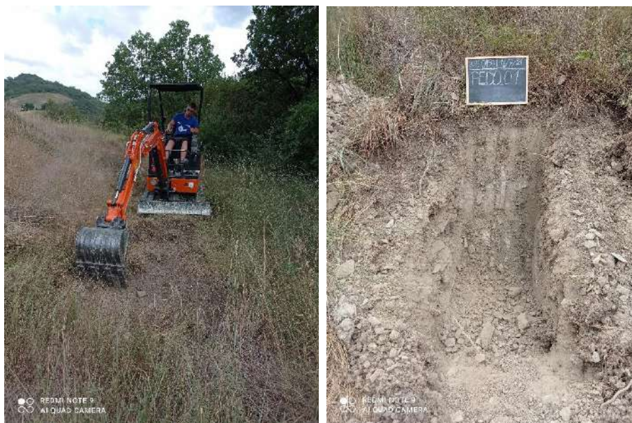
Posizionamento e pozzetto esplorativo
