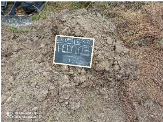
Cumuli materiale scavato: top soil (indicato nella foto con TS) e substrato
