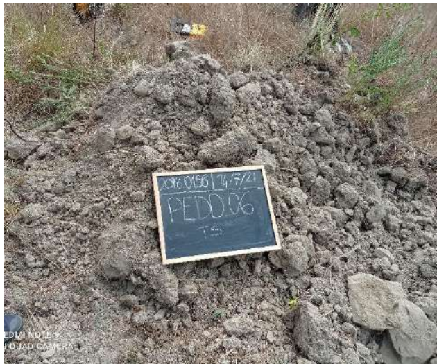
Cumuli materiale scavato: top soil (indicato nella foto con TS) e substrato
