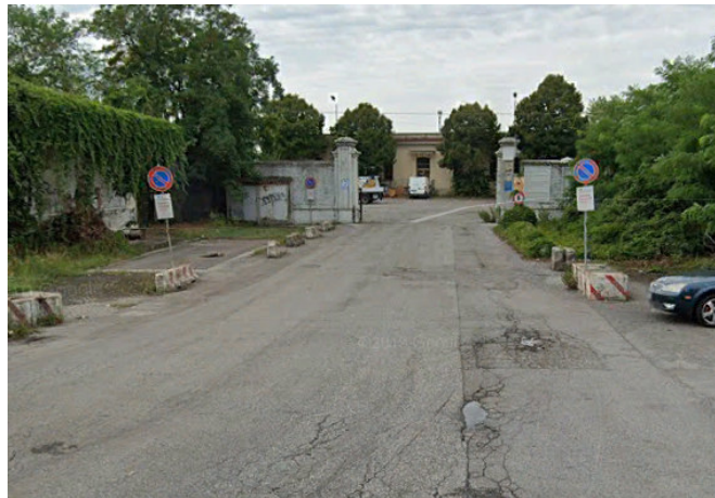
Accesso alle aree di cantiere da via Dalmazia (fonte Google Earth)
