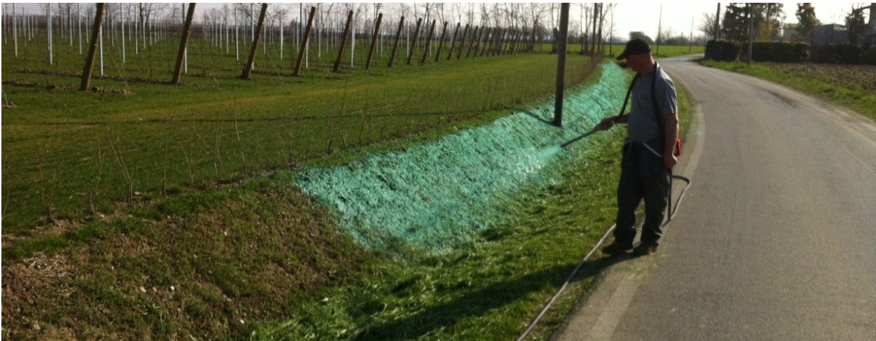
Figura 24 – Tecniche di idrosemina
