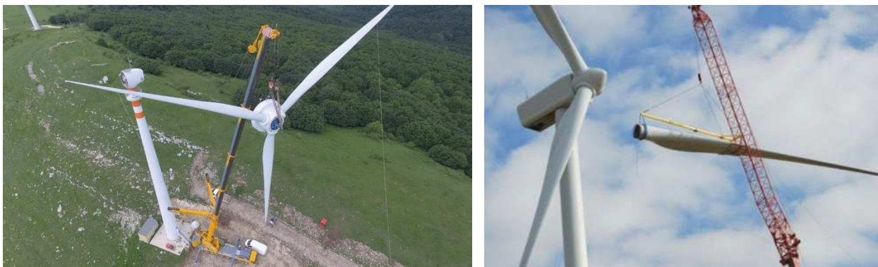
Figura 68 - Immagini della fase di montaggio di una turbina tipo
