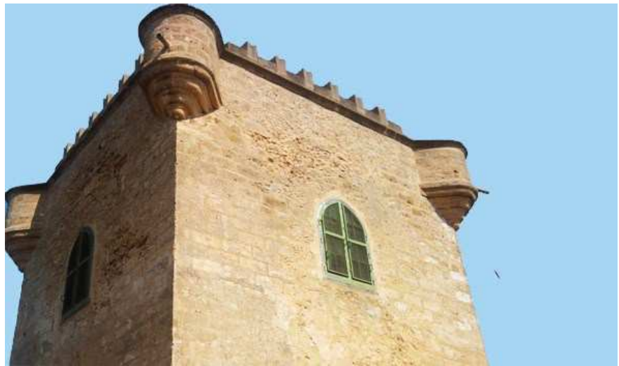
Figura 107 – Torre Busala a Mazara del Vallo
