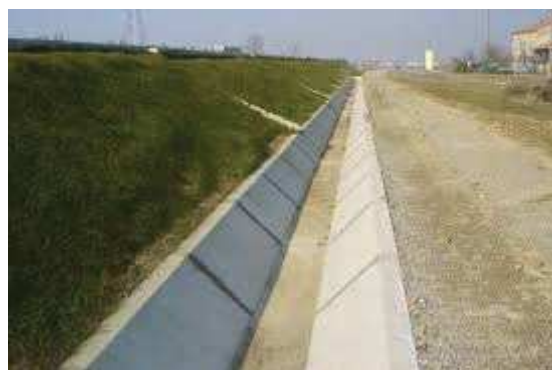
Figura 125 b - Esempio di cunette di raccolta e drenaggio delle acque meteoriche
