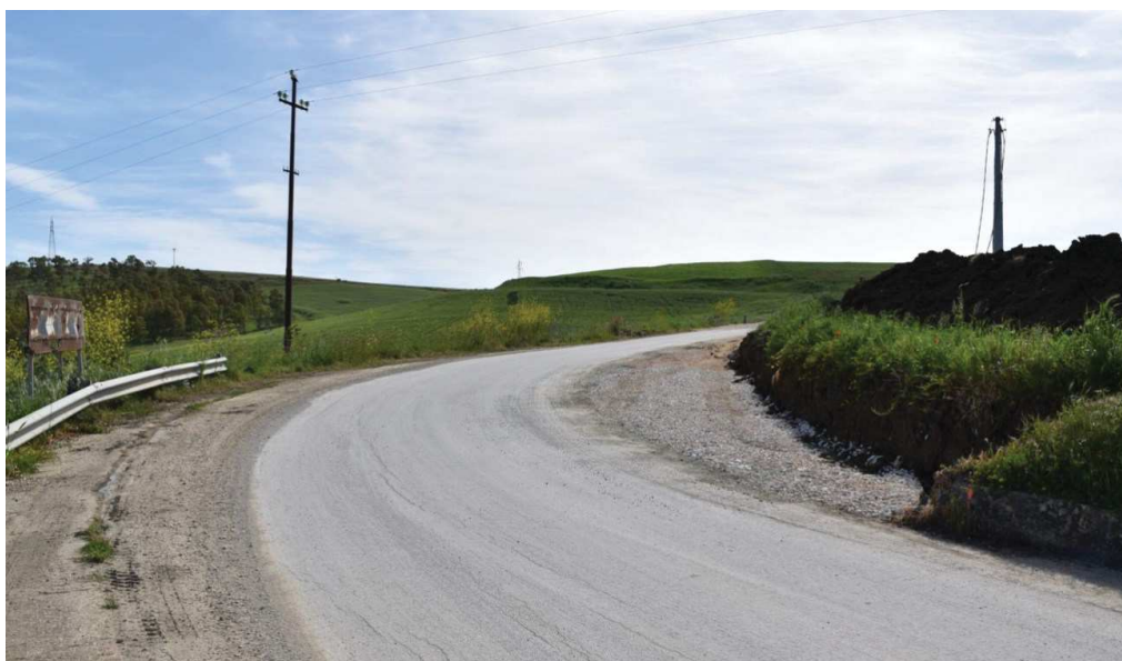
Figura 73 - Immagini sulla viabilità esterna/di accesso al parco eolico (Stato di fatto)
