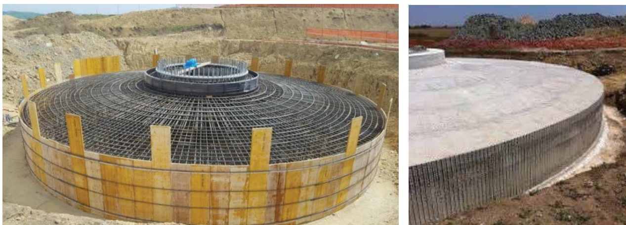
Figure 71 - Immagini fase di cantiere Fondazione tipo (sezione e armatura inferiore)
