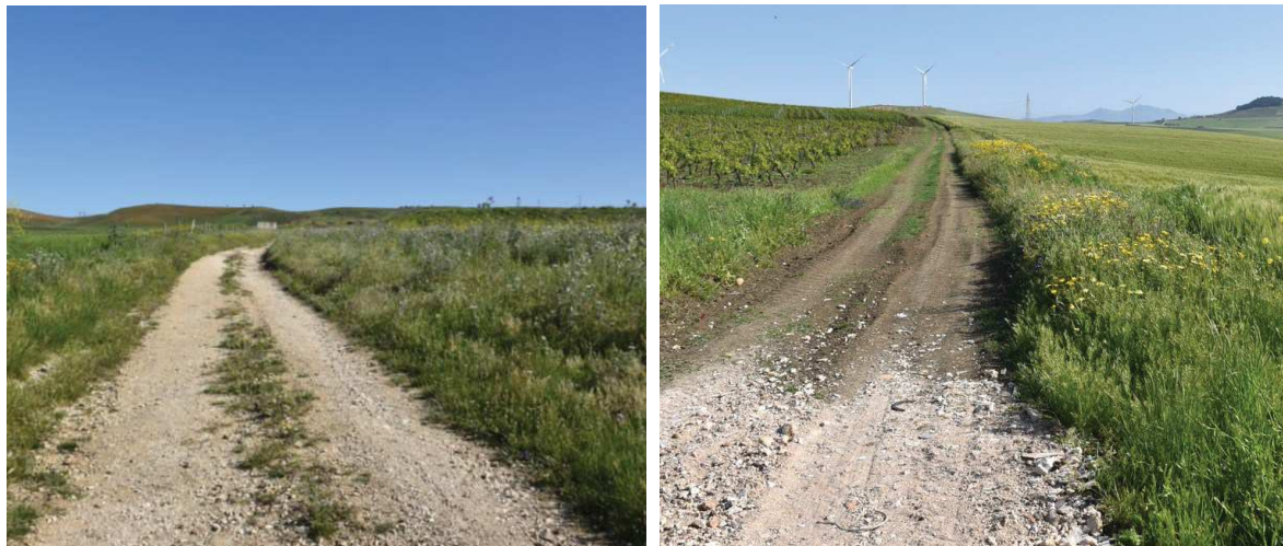
Figura 72 - Immagini sulla viabilità interna al parco eolico (Stato di fatto)
