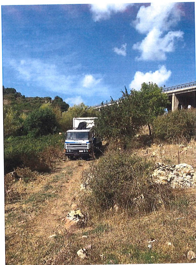
Particolare compressore per esecuzione Sondaggio S2 bis
