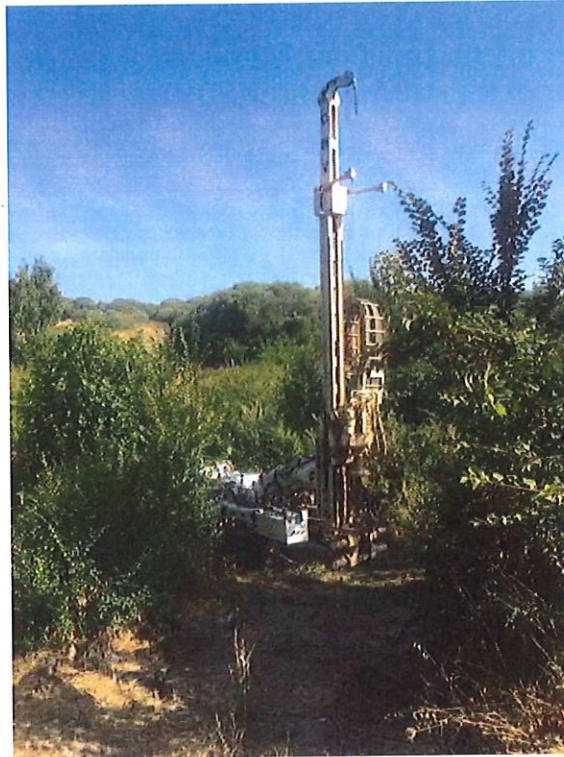
Fig. 2 – Esecuzione del sondaggio mediante perforatrice idraulica MK 900 D
