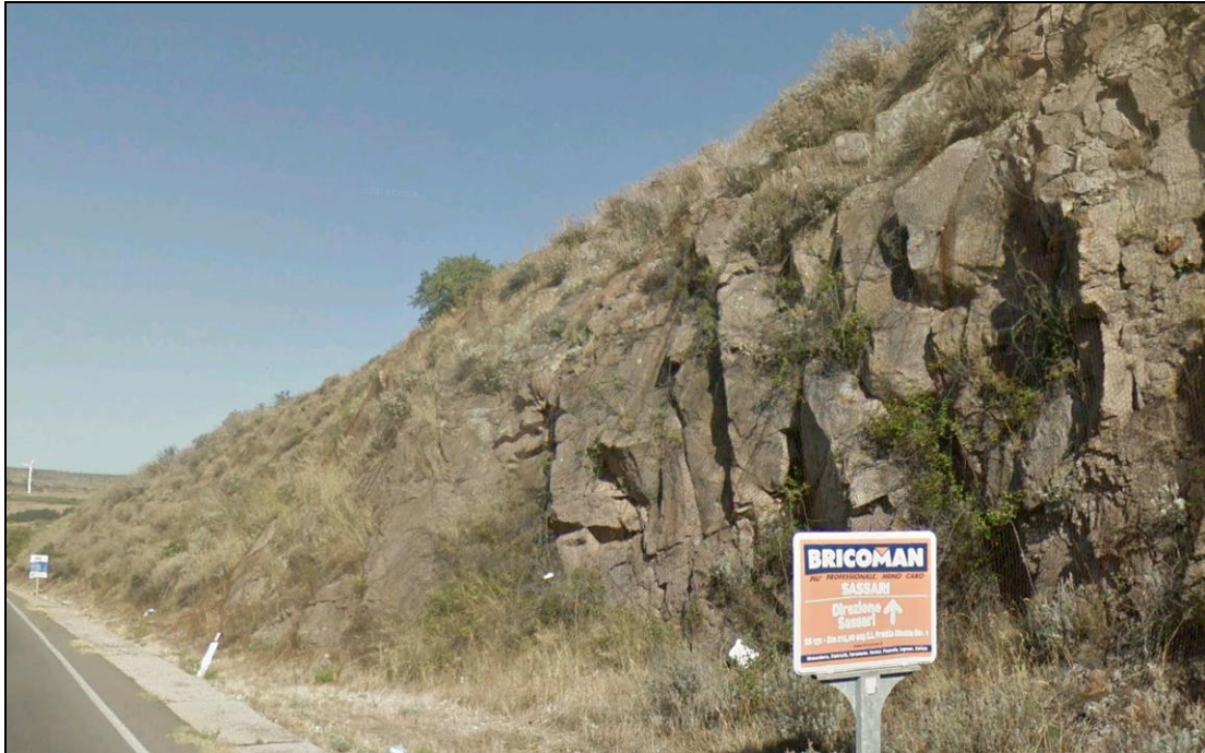
Foto 3 – Depositi piroclastici appartenente all'Unità di Bortigali affioranti lungo il km 145 della S.S.131.
