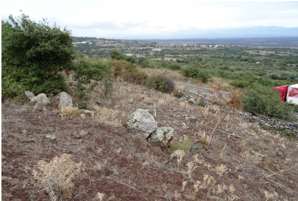
Foto 6 – Blocchi basaltici lungo il versante oggetto di potenziale rotolamento, a poca distanza dalle sede della S.S.131.
