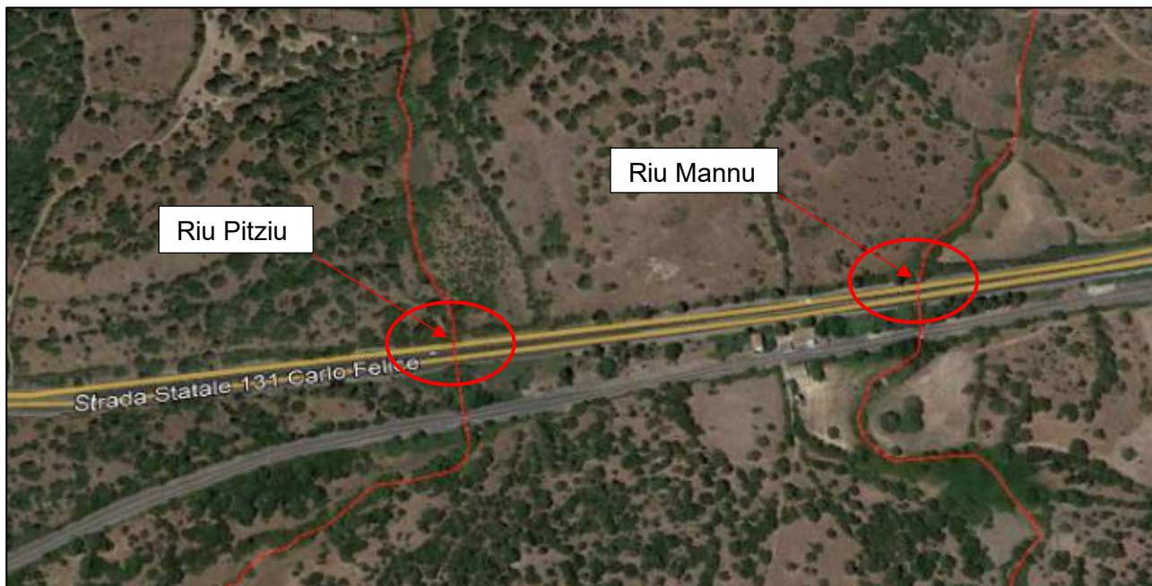
Figura 113 - Inquadramento dei punti di attraversamento dei Rii Mannu e Pitziu con la SS 131 ed il rilevato ferroviario
