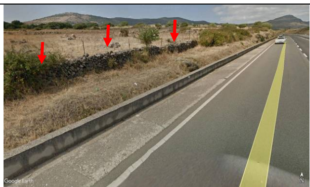
Foto 55d - Piazzola Km 140+630: panoramica - le frecce indicano il limite costituito dal muro di pietrame a secco
