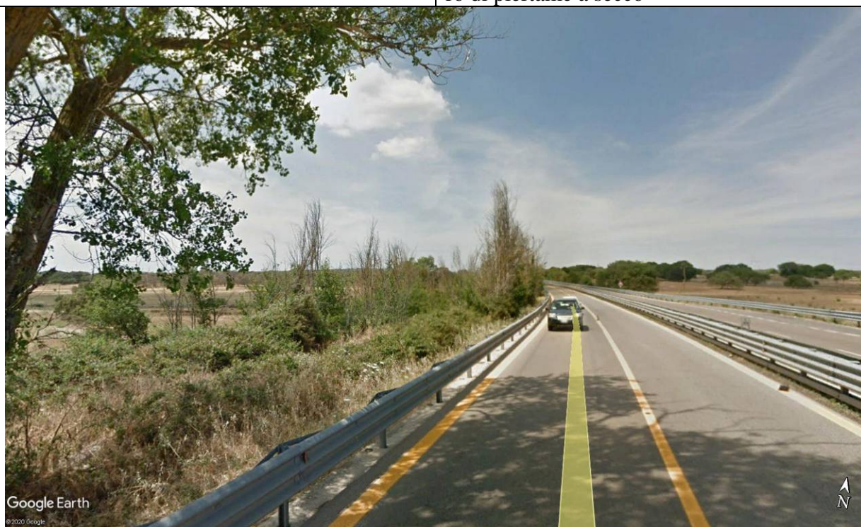
Foto 55e - Piazzola Km 153+120: panoramica
