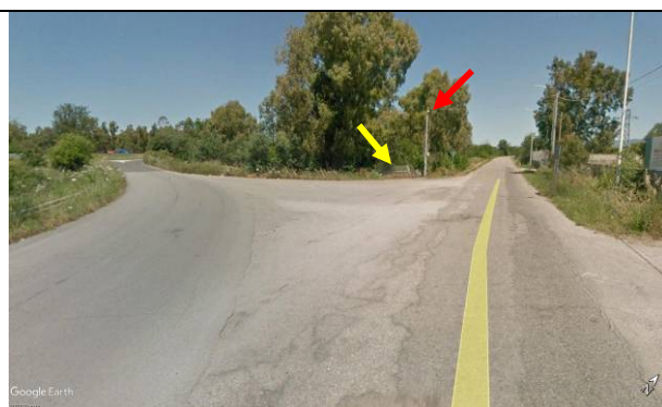
Foto 25b - Panoramica area intersezione con via Oristano. La freccia rossa indica il sostegno della linea elettrica di Bt; la freccia gialla indica la posizione del cancello di accesso.
