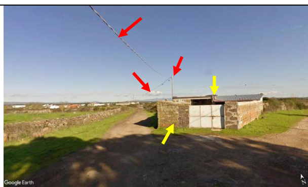
Foto 34b - Panoramica area incrocio con la viabilità di valle le frecce rosse indicano l'interferenza con in sostegni e la linea telefonica; le frecce in giallo indicano il fabbricato in muratura esistente nella zona.
