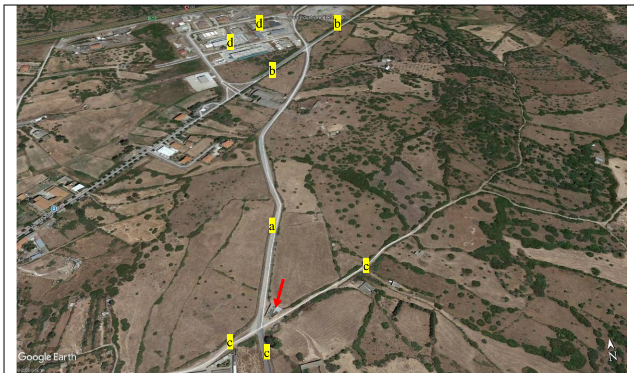
Foto 34 - Panoramica tracciato della S02; si evidenziano: a= il tracciato esistente; b= la viabilità di monte (via Nazionale); c= la viabilità di valle; d= gli insediamenti della zona industriale Paulilatino. La freccia in rosso individua il fabbricato esistente in corrispondenza dello svincolo di valle.
