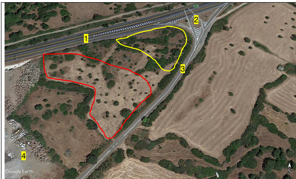
Foto 1 - Panoramica dell'area (perimetro in rosso) dove si evidenziano i seguenti elementi: 1= SS 131; 2= svincolo Paulilatino esistente; 3 = via Nazionale; 4= piazzale deposito materiali di cava. Il giallo viene anche riportato il perimetro dove è previsto l'insediamento del Campo Operativo CO.01
