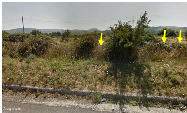
Foto 6 - Vista del confine est dal lato della SS131; le frecce in giallo indicano i tratti residui dei muri in pietra a secco.
