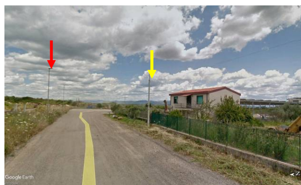
Foto 15 - Le frecce in giallo indicano la tipologia dei sostegni delle linee elettriche; le frecce in rosso indicano la tipologia dei pali di illuminazione stradale
