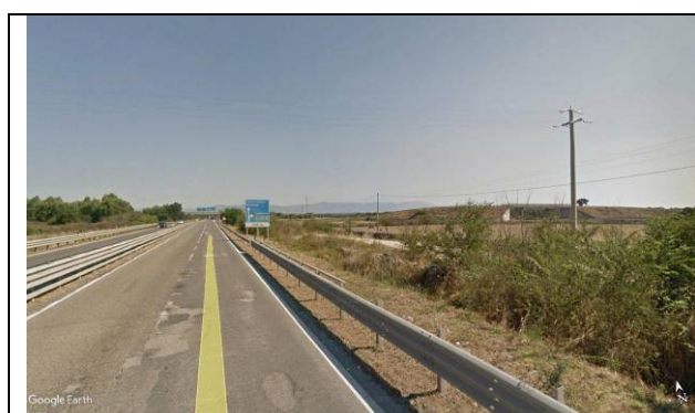
Foto 54g - SS131: attraversamento linea TERNA
