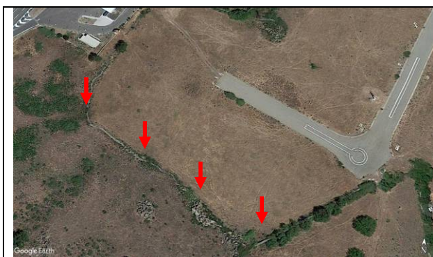
Foto 37a: panoramica sezione di innesto alla viabilità della zona industriale; le frecce indicano le linee di confine delimitati da muri in pietrame a secco
