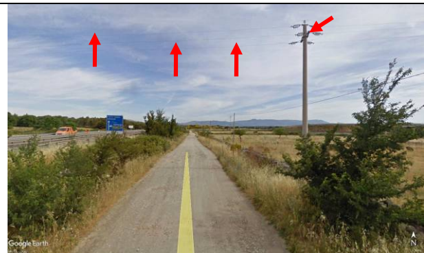
Foto 54e - Locale B: linea MT interferente
