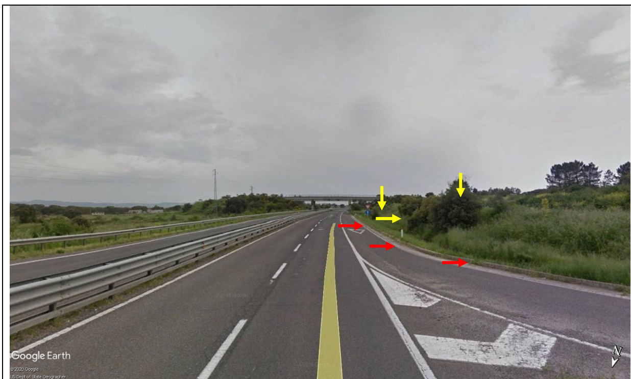
Foto 26c - Panoramica area corsia di accelerazione carreggiata sud immissione da Norbello dove si evidenziano: la cunetta in cls (freccette rosse); la scarpata con presenza di essenze arbustive e vegetazione xerofila (freccette gialle)
