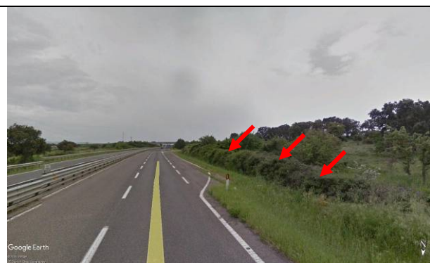
Foto 26b - Panoramica corsia di decelerazione carreggiata sud uscita per Norbello. Le frecce indicano la vegetazione arbustiva presente sulla scarpata
