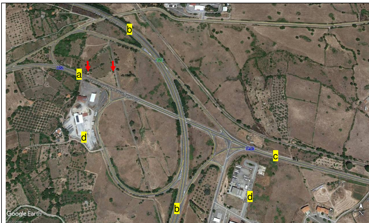
Foto 20 - Panoramica generale dello svincolo Macomer sud dove si evidenziano i seguenti elementi: a= asse della SS 129; b= asse della SS131; c= asse della SP 57; d= insediamenti industriali; le frecce in rosso individuano i fabbricati residenziali presenti all'interno delle aree intercluse dello svincolo.
