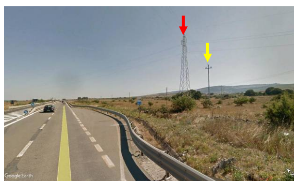
Foto 19c - La freccia rossa indica il traliccio della linea Terna AT presente nell'area del nuovo svincolo; la freccia gialla indica uno dei tralicci in cls della linea ENEL in Mt interferente.
