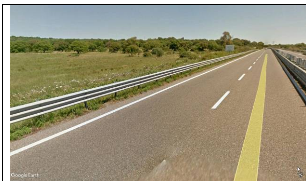
Foto 55a - Piazzola Km 121+450: panoramica
