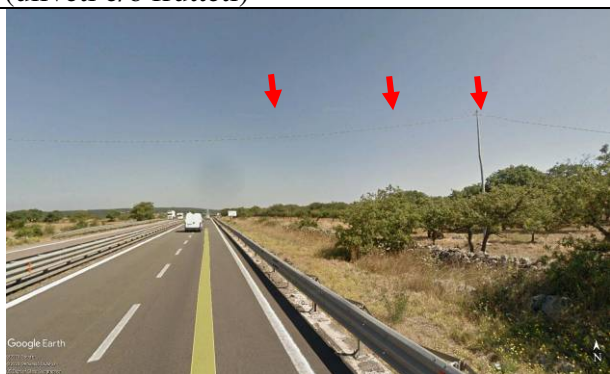
Foto 48g - S17 CN: attraversamento linea Bt sez. 110 (freccette rosse)
