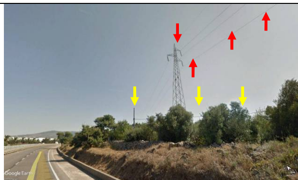
Foto 37d: interferenza con la rete Terna di AT (frecce rosse) e telefonica (frecce gialle)
