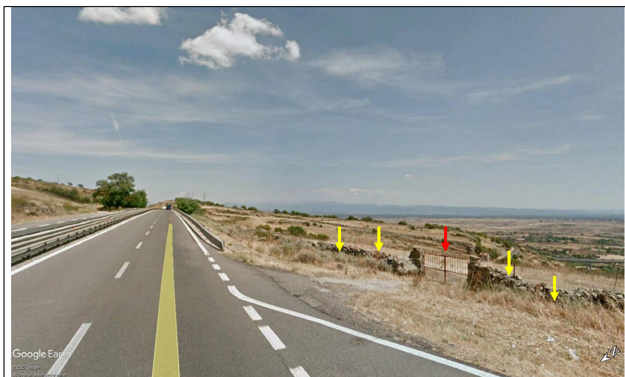
Foto 28e - Panoramica zona di valle carreggiata sud dove si evidenziano il cancello di ingresso (freccia rossa) e i muretti di confine (freccie gialle)
