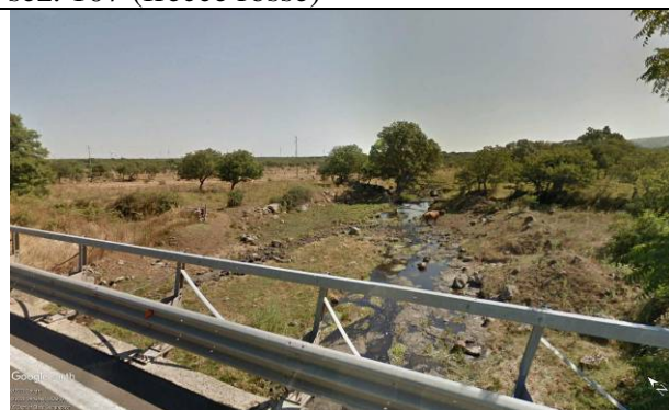
Foto 48h - S17 CN: attraversamento torrente sez. 15-18)
