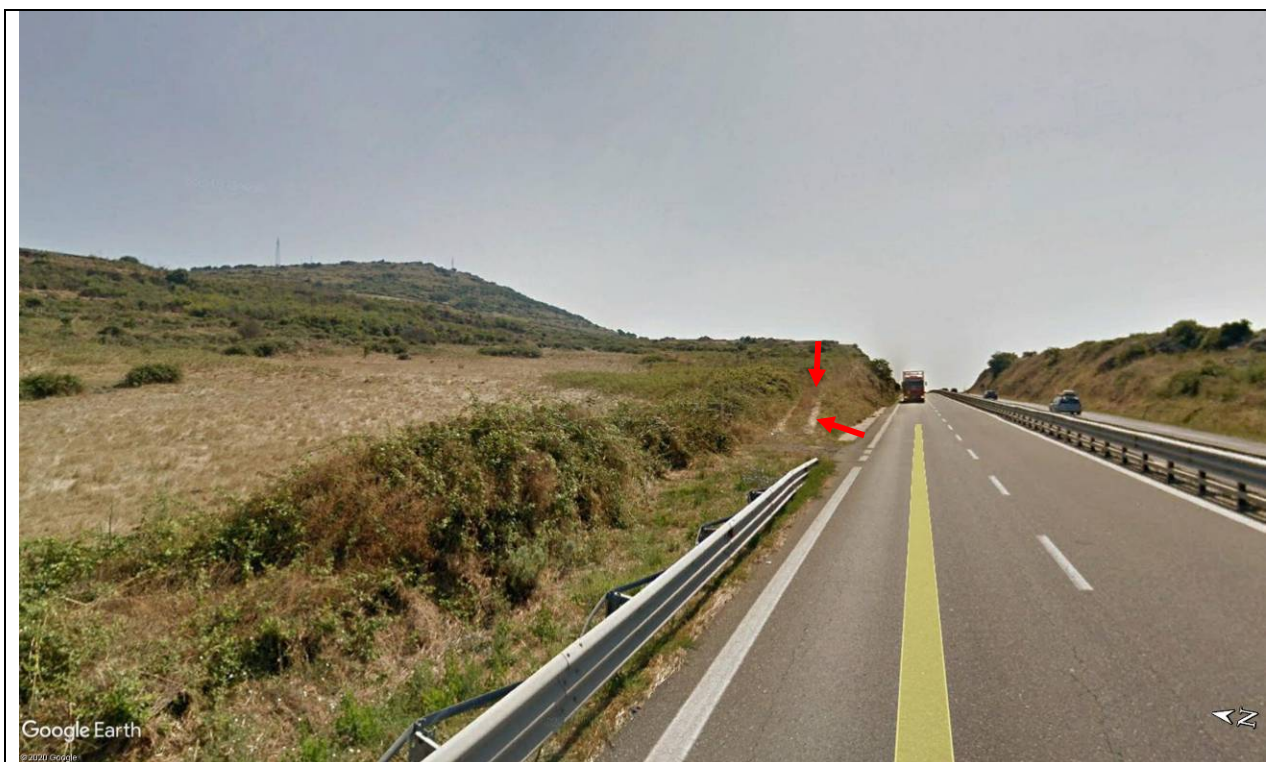
Foto 44a - S13 CN: Panoramica area di intervento; le frecce indicano la pista in terra battuta esistente.
