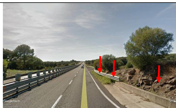
Foto 24b - Panoramica area di intervento carreggiata sud; le frecce indicano le caratteristiche della scarpata e della cunetta
