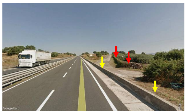
Foto 36d - CN: panoramica zona di innesco sez. 92; le frecce rosse indicano i muretti in pietra; le frecce gialle indicano la cunetta in cls.
