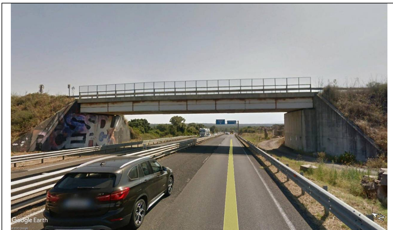
Foto 56 - Panoramica cavalcavia Paulilatino Km 120+316 da mantenere
