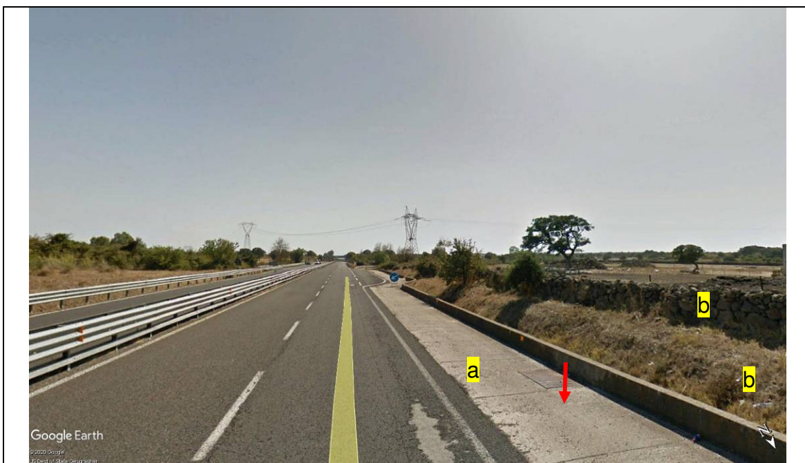
Foto 23 - Uscita Nuraghe Losa. Si evidenziano i seguenti elementi: a= cunetta in cls; b= scarpata con arbusti e muretto in pietrame a secco. La freccia rosso indica la caditoia stradale con griglia metallica.
