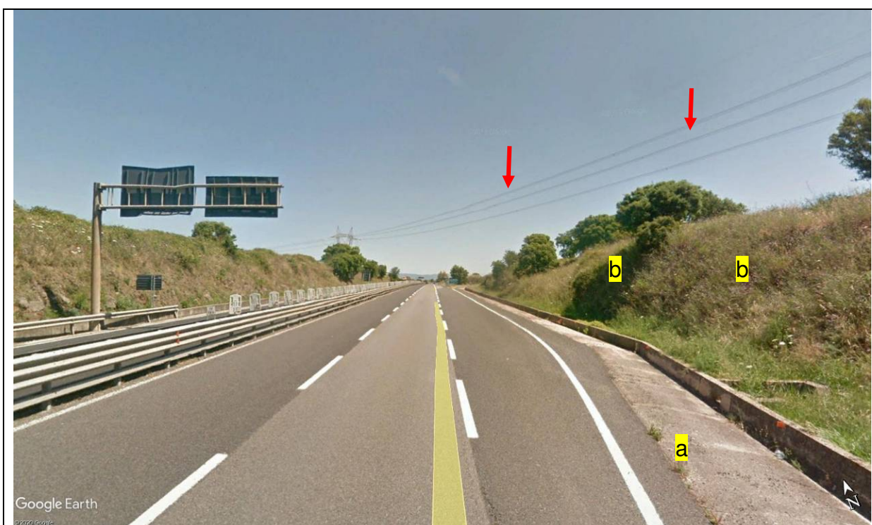
Foto 23b - Uscita per Nuraghe Losa. Si evidenziano i seguenti elementi: a= cunetta in cls; b= scarpata con arbusti. Le frecce rosse indicano l'interferenza con la linea Terna di A.T.
