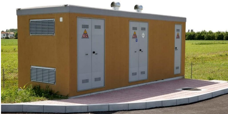
Figura 26 - Immagina di una cabina di consegna specifica DG2092 Rev.03 del 15/09/2016
