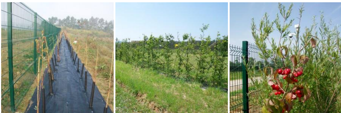
Figura 20 - Esempio di barriera verde su un impianto fotovoltaico
