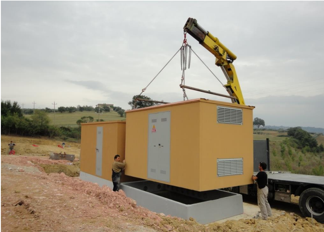
Installazione cabine elettriche prefabbricate
