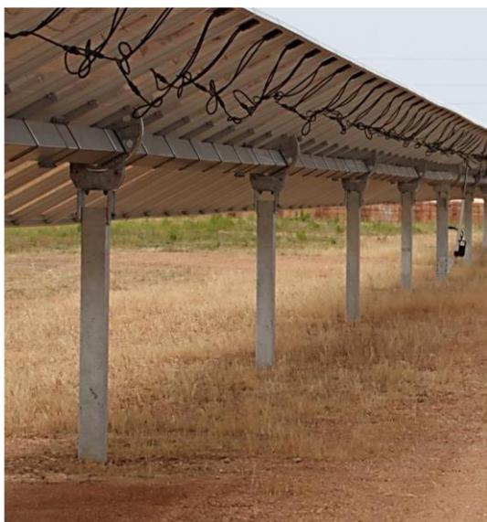
Foto1: Pile guidate speronate direttamente nel terreno
