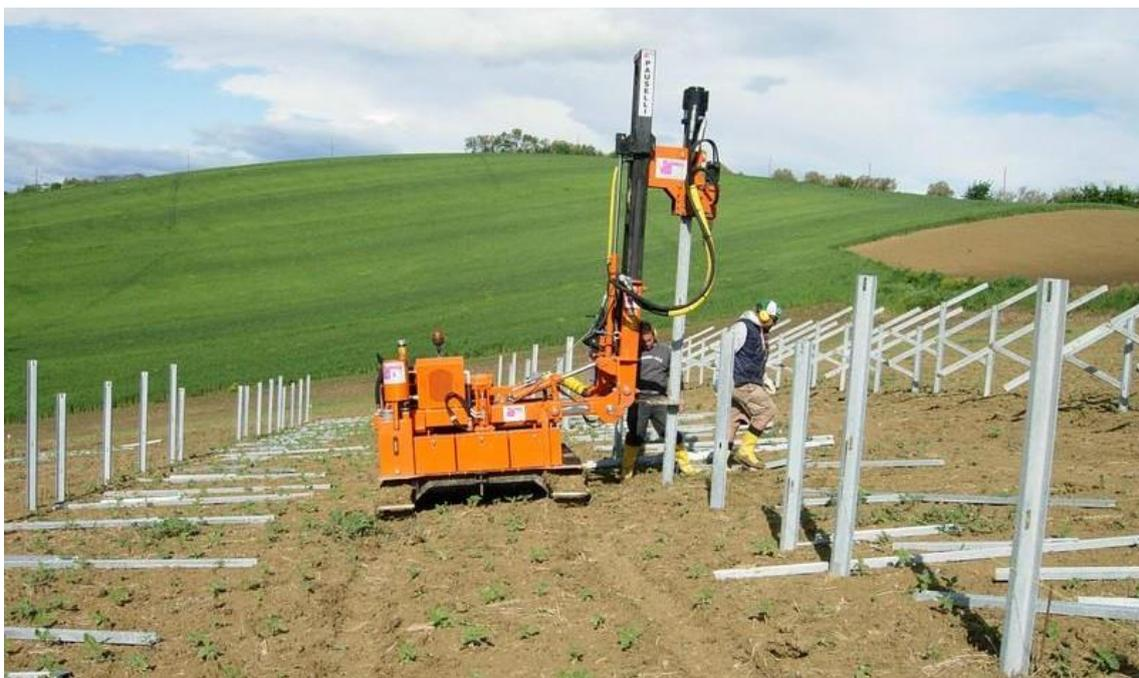
Battipali per la struttura di supporto degli inseguitori solari
