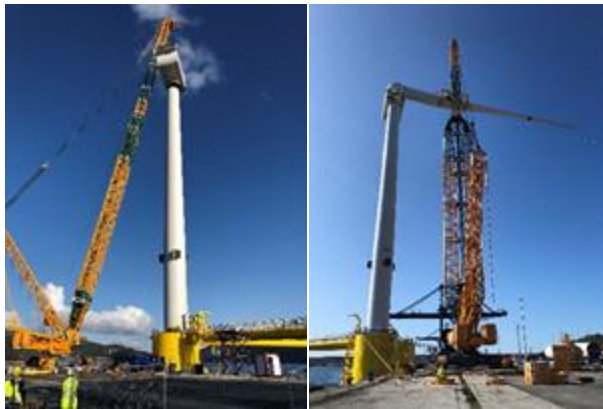
Figura 3.21 Installazione della turbina eolica sulla piattaforma galleggiante.
