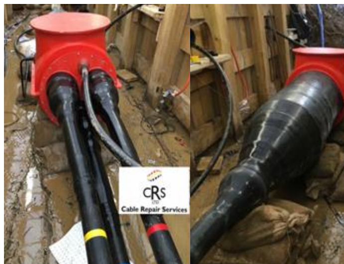
Figura 3.12 Transition Joint Bay sulla terraferma.
