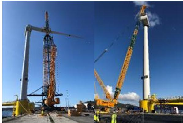
**Figura 34: Installazione della turbina eolica.**
