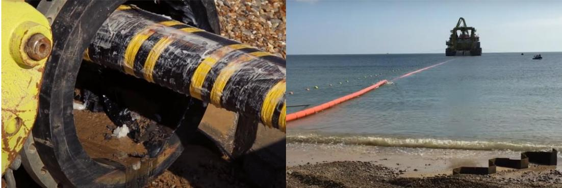
**Figura 43: Inserimento di un cavo export offshore sulla riva.**
