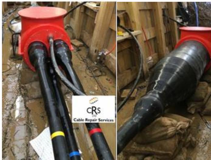
**Figura 40: Giuntura di transizione sulla terraferma.**
