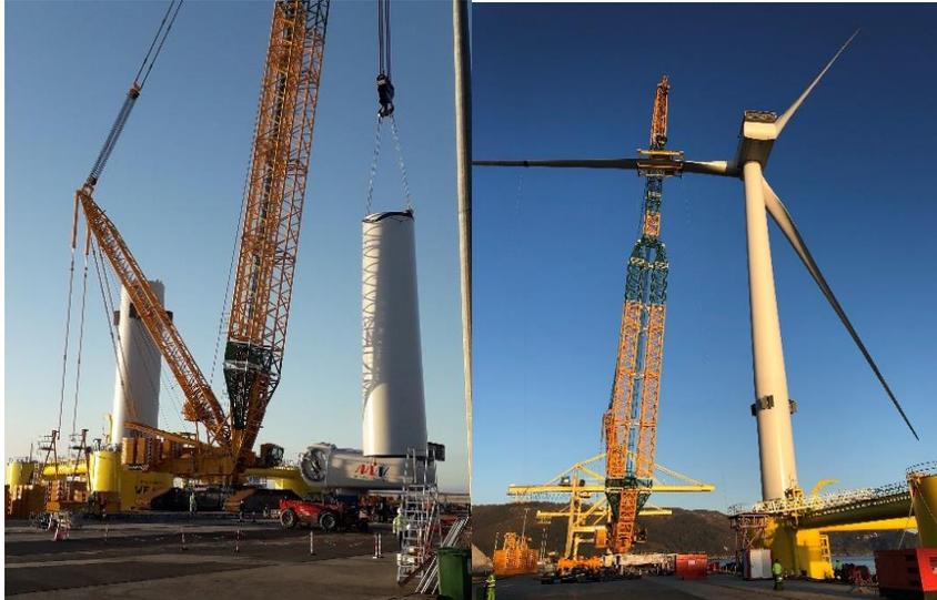
**Figura 60: Installazione della torre e della turbina.**
