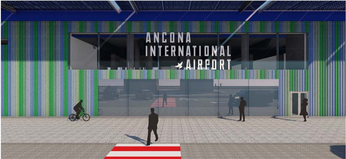
Land-side asse centrale
