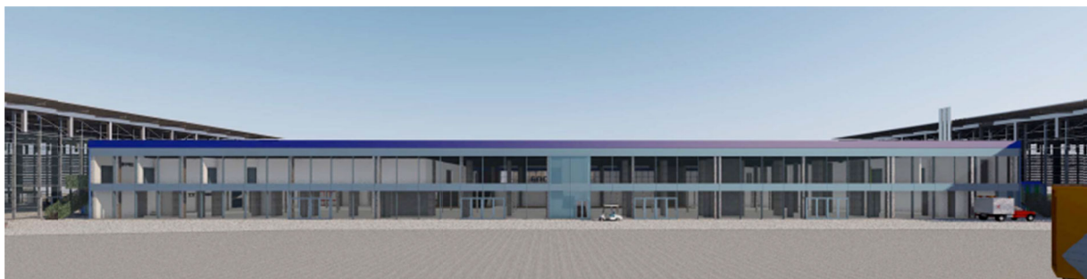
Inserimento fotografico-lato air side
