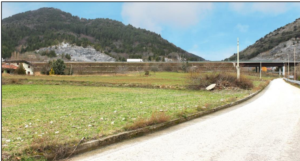
Figura 28 - L'area di intervento della rampa 2-2 di uscita dalla carreggiata sud- Stato Ante operam
