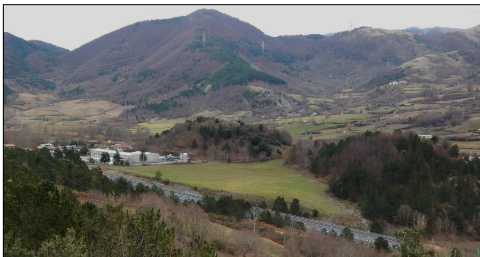
Figura 25 - L'area di intervento della rampa 2-2 di ingresso alla carreggiata sud- Stato Ante operam
