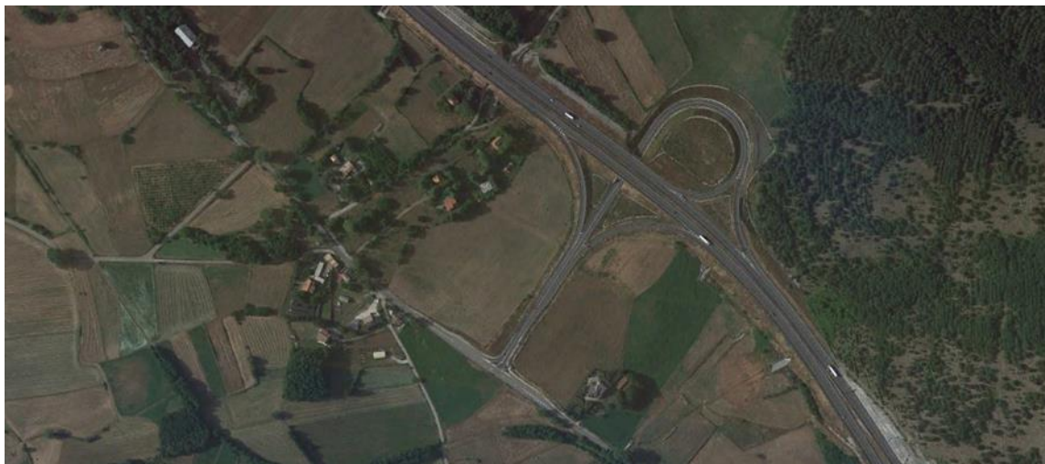
Figura 4 - Svincolo di Campotenese
