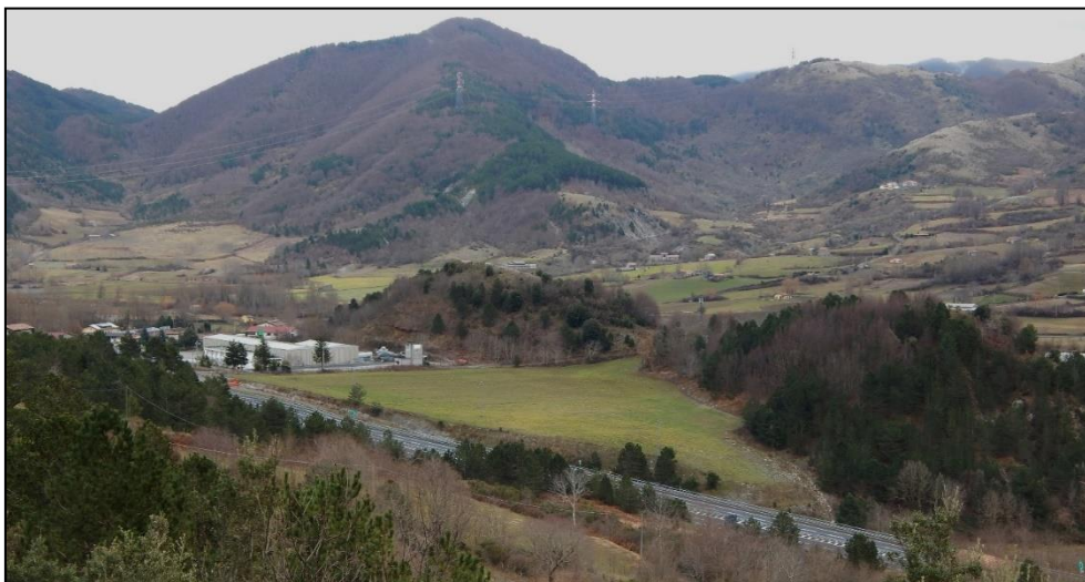
Figura 62 - L'area di intervento della rampa 2-2 di ingresso alla carreggiata sud- Stato Ante operam
