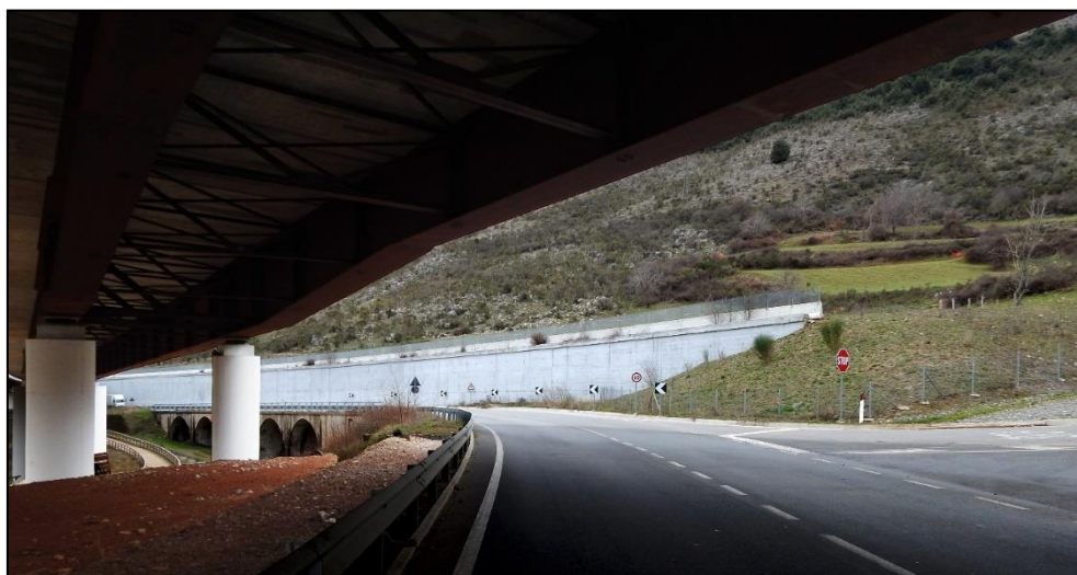
Figura 68 - L'area di intervento della rotonda A-2- Stato Ante operam
