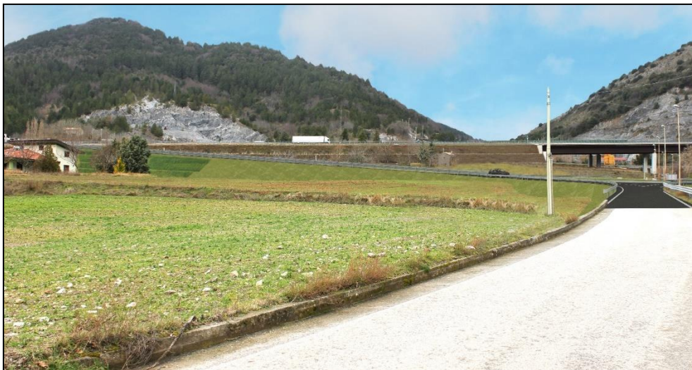
Figura 66 - Stato post operam
