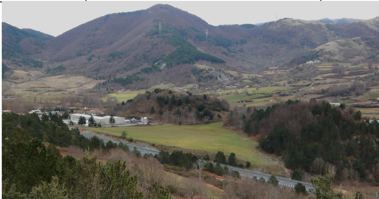
Fig 9. L'area di intervento della rampa 2-2 di ingresso alla carreggiata sud- Stato Ante operam
