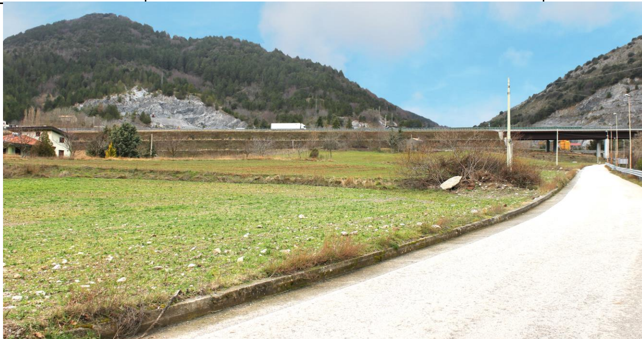
Fig 11. L'area di intervento della rampa 2-2 di uscita dalla carreggiata sud- Stato Ante operam
