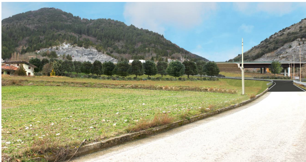
Fig 12. Stato post operam con gli interventi di mitigazione
