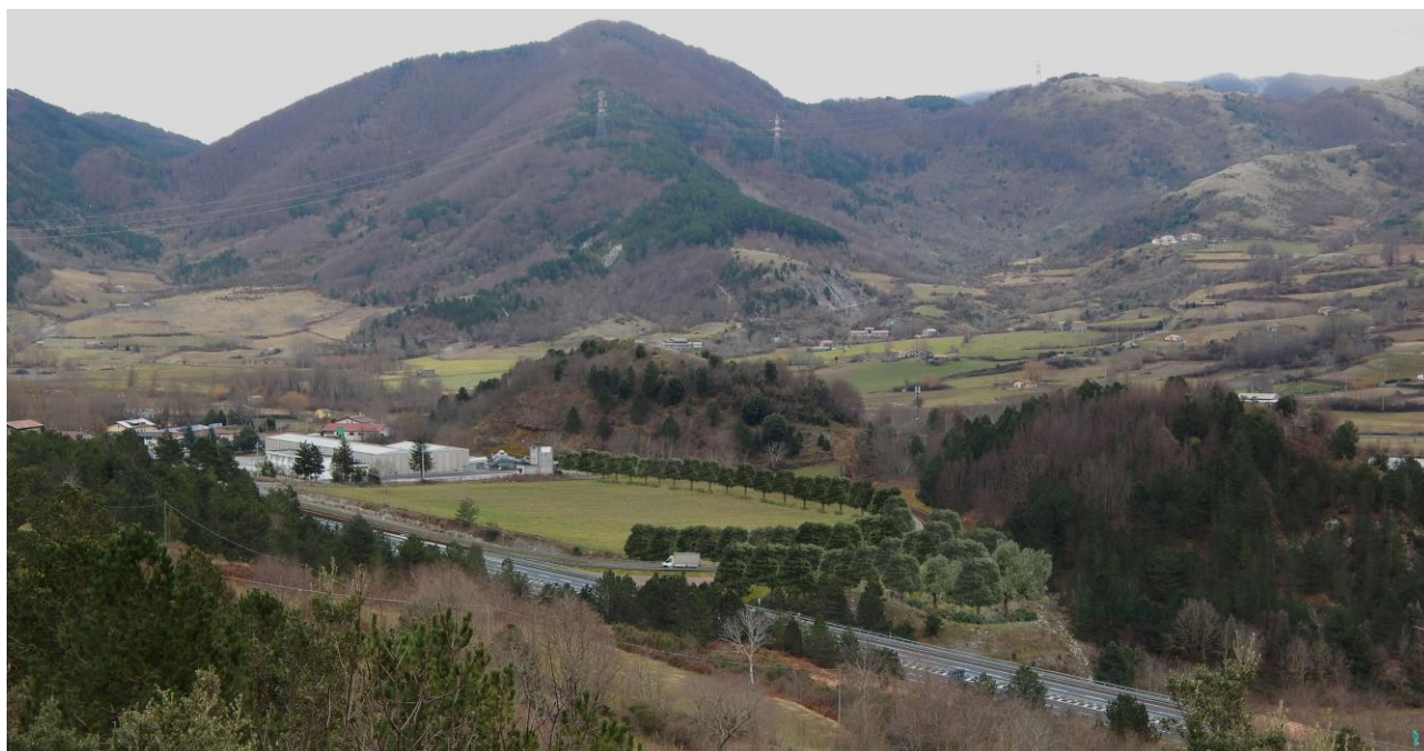
Fig 10. Stato post operam con gli interventi di mitigazione
