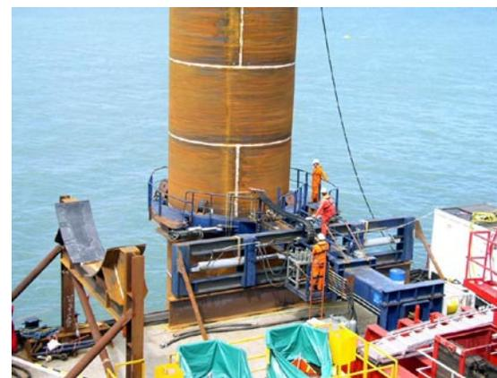
Figura 1.42 Operazione posizionamento del monopalo delle fondamenta
