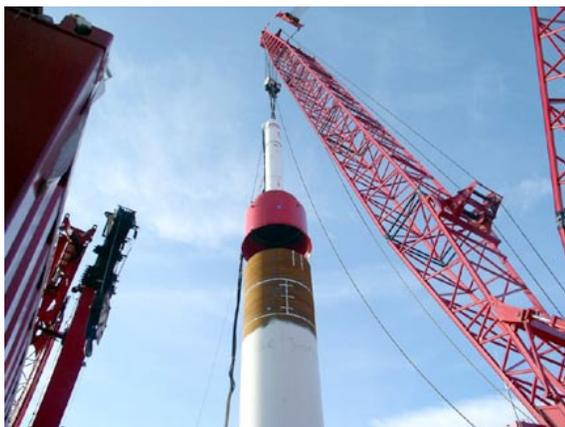
**Figura 1.43** Operazione di “battitura” del monopalo
