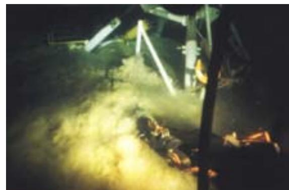
**Figura 1.45** Ripresa subacquea dell'uso di una lancia idraulica
