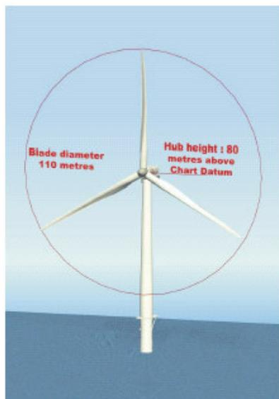
Figura 1.38 Dimensioni caratteristiche delle turbine proposte per la realizzazione dell'impianto
