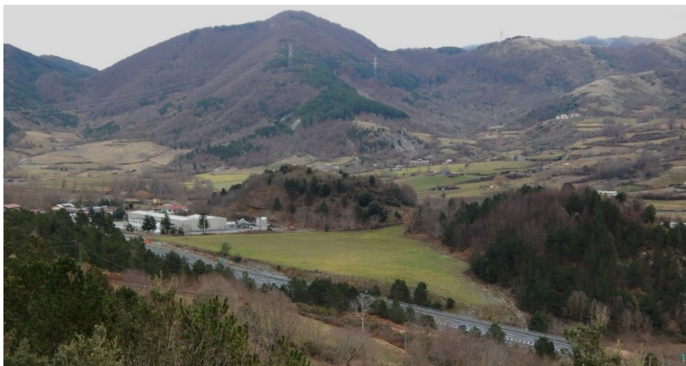
Area di intervento Rampa 2-2 ingresso Autostrada: stato attuale dei luoghi
