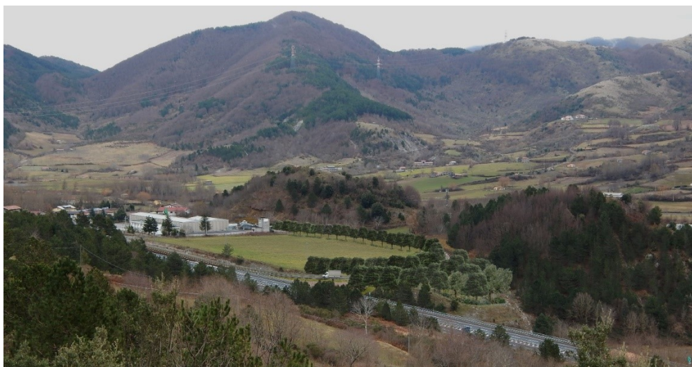
Area di intervento Rampa 2-2 ingresso Autostrada: post operam con fascia arborea di mitigazione
