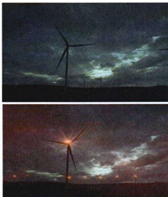
(modello di illuminazione notturna di un aerogeneratore tratto dall'elaborato integrativo progetto codice MITE-VA ID_VIP 5471 - "Relazione segnalazione cromatica e luminosa per la sicurezza del volo aereo in fase "diurna" e "notturna" – p. 15)
