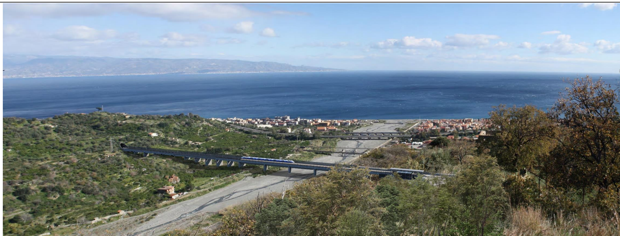
Vista 2 – Viadotto Fiumedinisi
