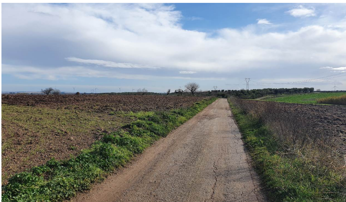
Foto P7.2: Vista della viabilità secondaria interessata dal passaggio del cavidotto interno, in prossimità dell'aerogeneratore ATM 4
