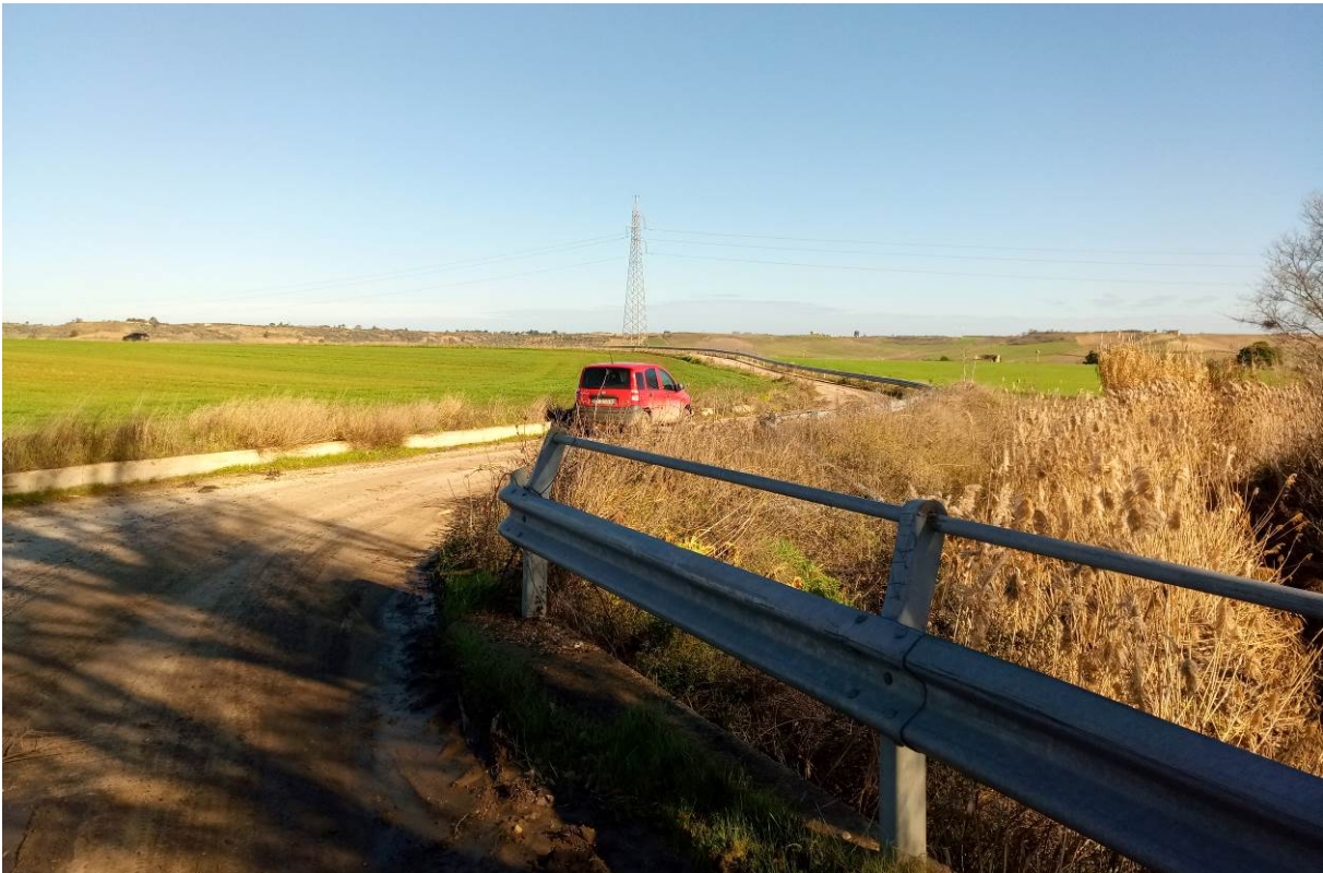
Foto P12.1: Vista della viabilità secondaria esistente interessata dal passaggio del cavidotto interno, in prossimità dell'attraversamento del reticolo idrografico secondario, in direzione turbina ATM 9
