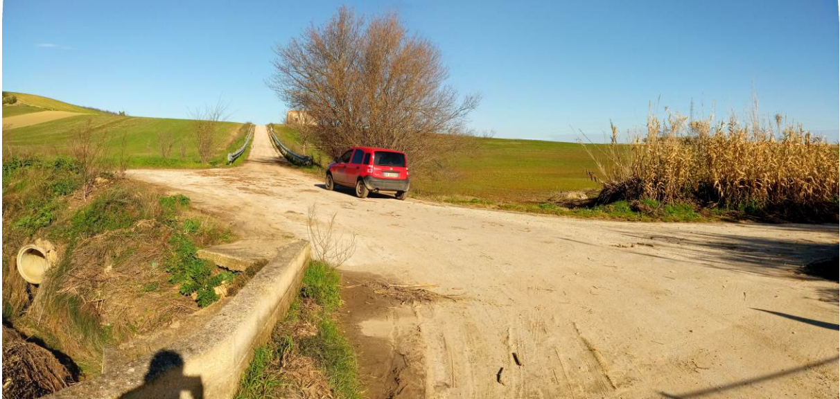
Foto P16.1: Vista della viabilità interna esistente da adeguare verso l'aerogeneratore ATM 12 in prossimità dell'attraversamento di due reticoli idrografici secondari, interessati dal passaggio del cavidotto in TOC
