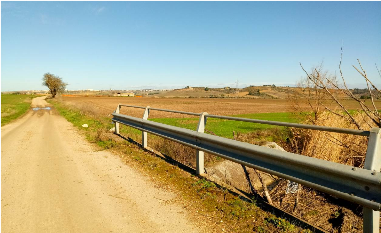
Foto P3.1: Vista della viabilità secondaria interessata dal passaggio del cavidotto interno, in prossimità dell'attraversamento del reticolo idrografico secondario in direzione turbina ATM1
